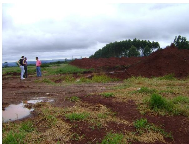
FOTO 4.8 – ÁREA DE VALAS COBERTAS NO ATERRO SANITÁRIO
