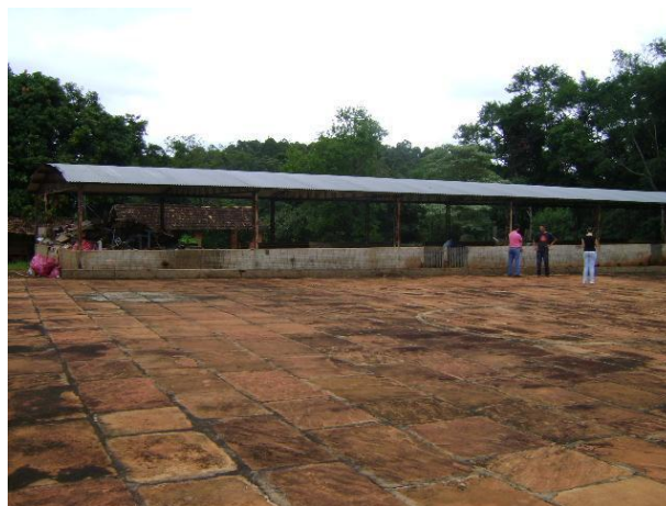
FOTO 4.10– VISTA DO GALPÃO DA TRIAGEM DA COLETA SELETIVA EM TIMBURI
