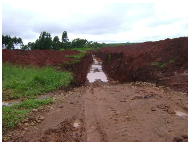
FOTO 4.7 - VALA ABERTA DO ATERRO SANITÁRIO DE TIMBURI
