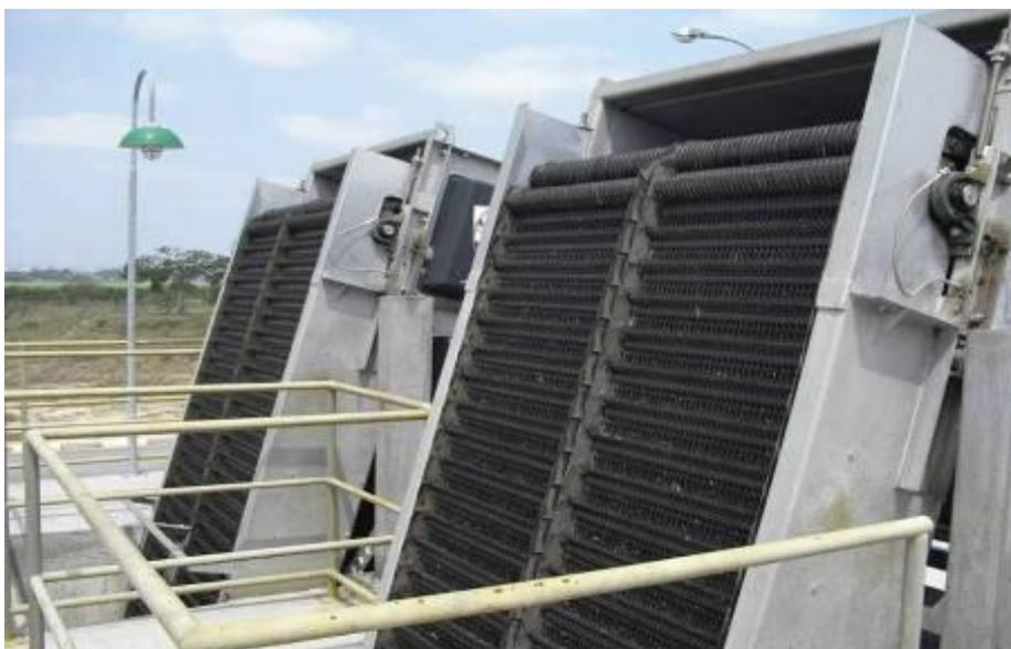
**Foto 15 – Gradeamento Mecanizado para Retirada do Material Grosseir.)**
