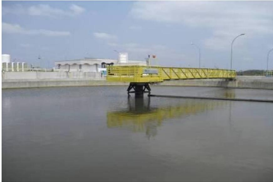
**Foto 19 – Decantador com Remoção Mecânica de Lodo.**
