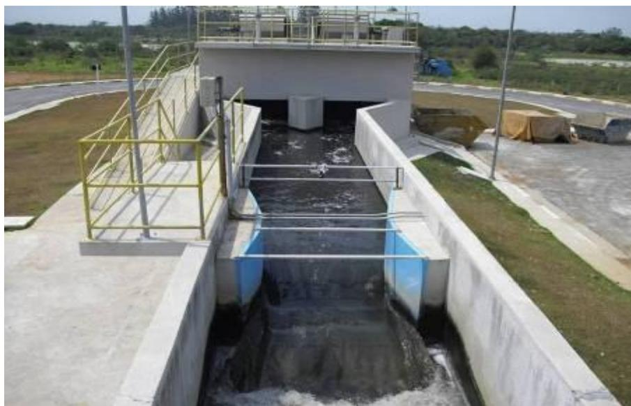
Foto 14 – Medição de Vazão Afluente – Calha Parshall.
