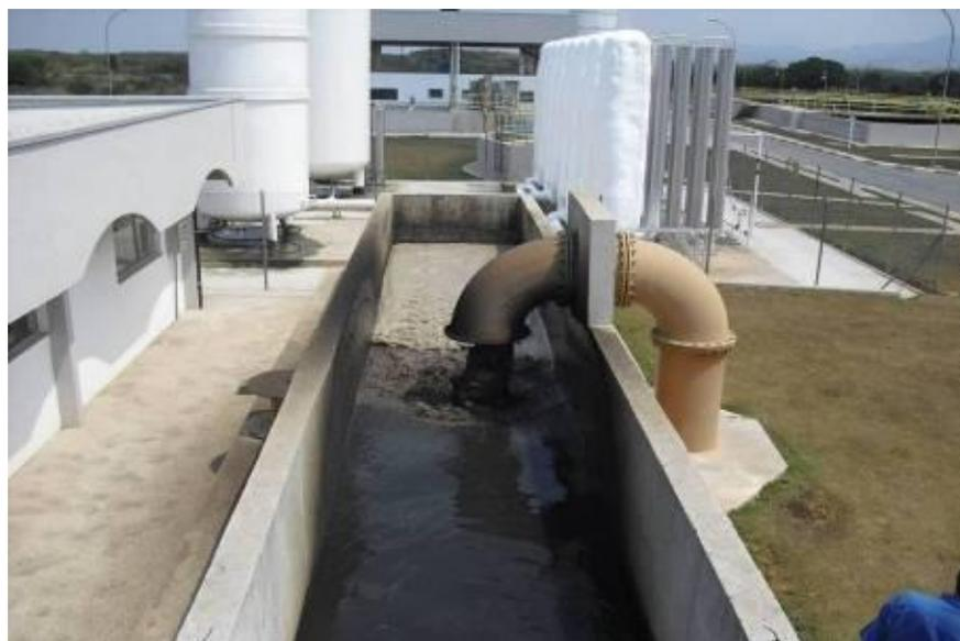
Foto 21 – Retorno de Lodo à Entrada dos Tanques de Aeração.
