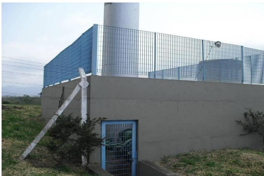
Foto 09 – Tanque de amortecimento unidirecional 01 (TAU) na adutora de água bruta Paraíba do Sul.
