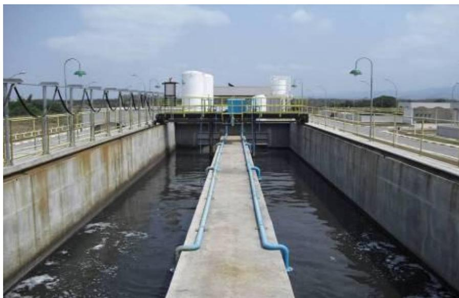
**Foto 16 – Caixa de Areia Mecanizada.**
