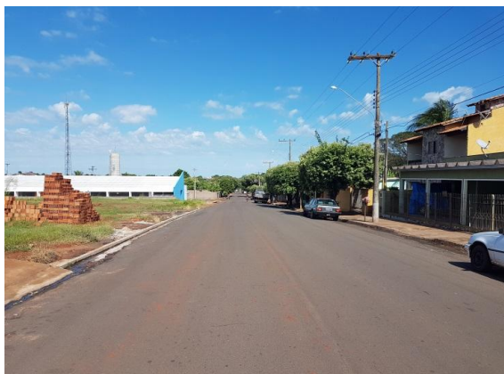
Foto 3.1 – Vista da Avenida Cláudio Fogaça, por onde a água esco superficialmente
