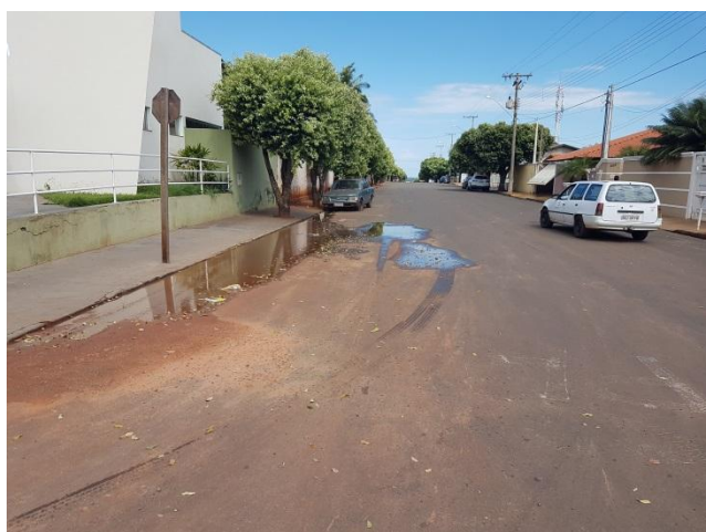
Foto 3.9 – Alagamento Rua Antônio R. Martins por falta de estrutura de microdrenagem
