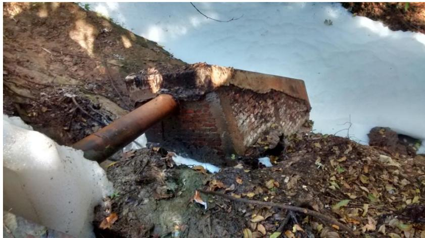
**5-14 Caixa de aeração rompida devido ao deslocamento de terra**
