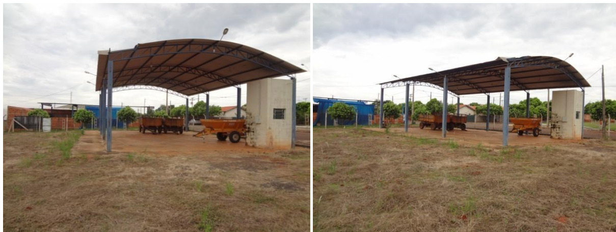
Figura 4 - Barracão de Receptação Material da Coleta Seletiva
