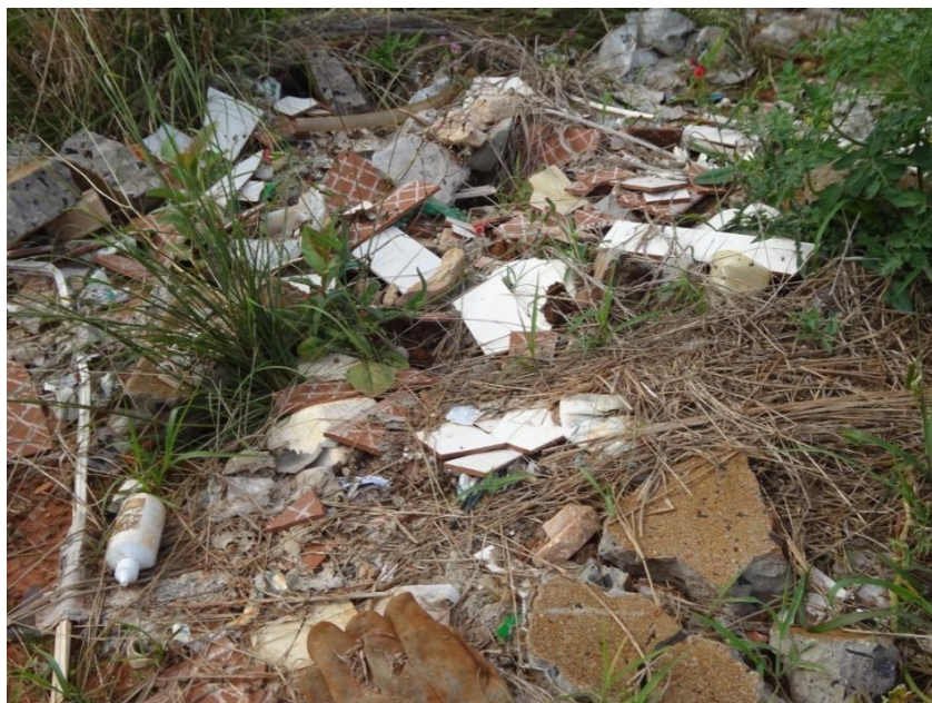
Figura 12 - Depósito de Resíduos da Construção e Demolição
