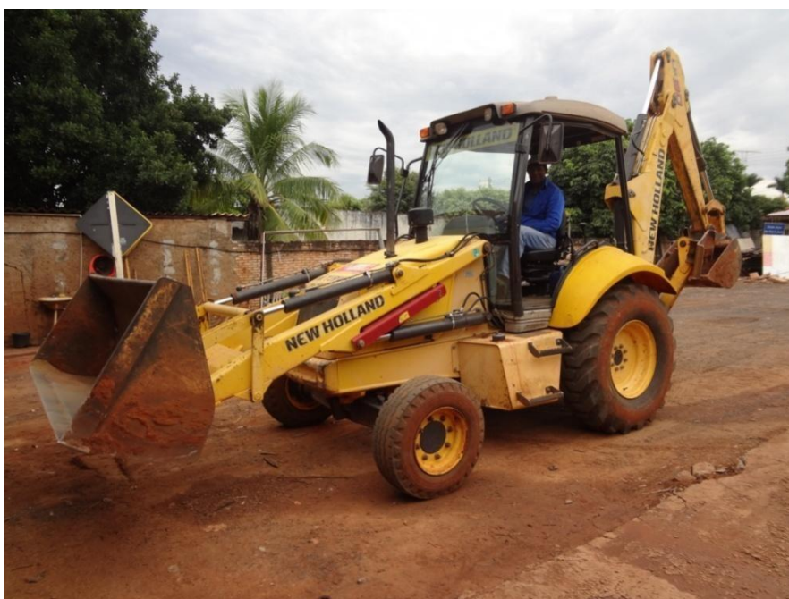
Figura 8- Retroescavadeira utilizada para limpeza
