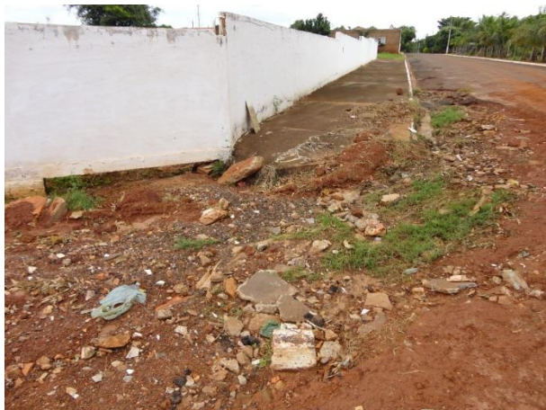
Foto 3.7 – Local de carreamento de solo e asfalto no final da Rua Guanabara, próximo ao cemitério municipal
