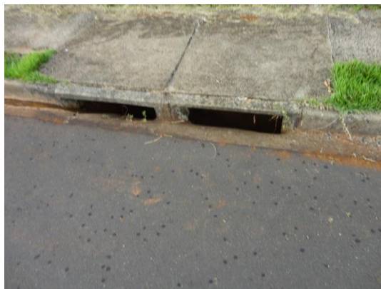
Foto 3.4 – Boca de lobo dupla da Rua Mato Grosso
