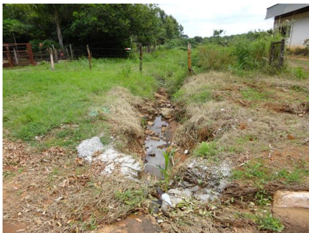
Foto 3.5 – Dissipação da galeria da Rua Mato Grosso
