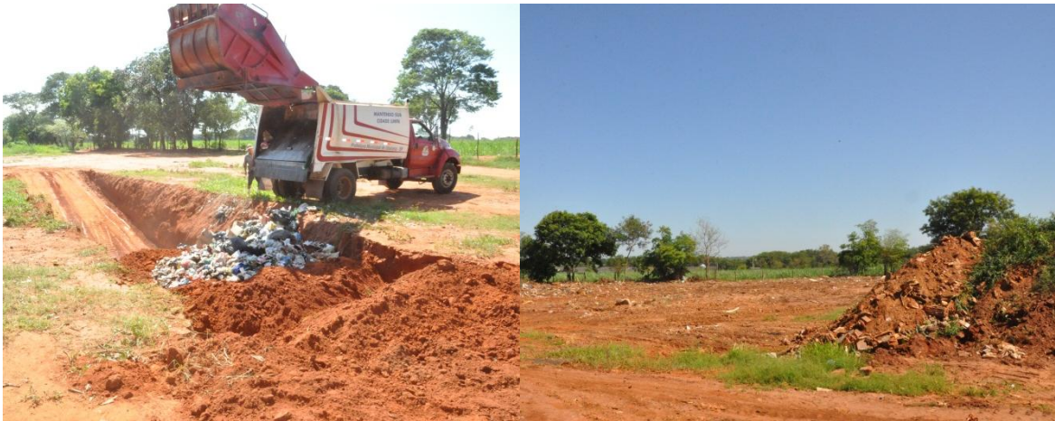
Imagem 8.3: Aterro em Valas de Ubarana.
