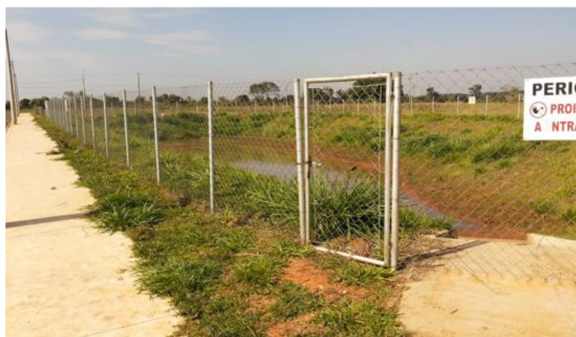
Imagem 11.11: Bacia de contenção em loteamento recém lançado.
