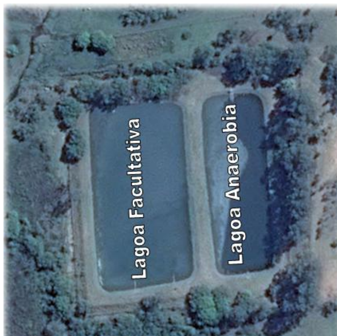
Figura 10.4: Vista aérea da Estação de Tratamento de Esgoto de Ubarana. Fonte: Google Earth
