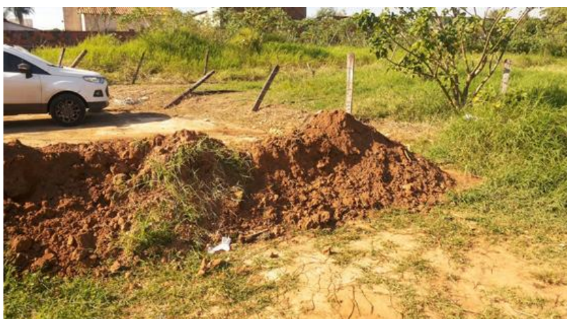
Imagem 11.2: Barreira provisória para contenção de águas pluviais.
