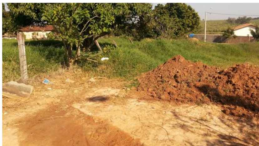
Imagem 11.3: Lançamento e águas pluviais em curva de contenção.
