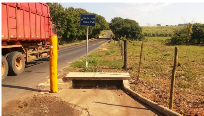
Imagem 11.5: Captação de águas pluviais bem preservada.
