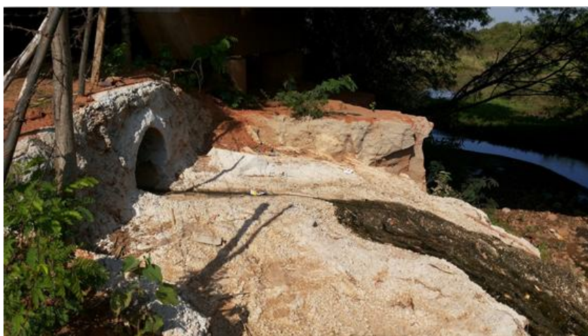
Imagem 11.6: Lançamento de águas pluviais no Córrego Bacaina.
