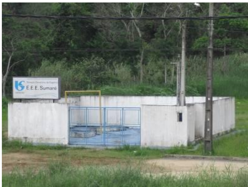
Foto 05 – EEE Sumaré – Sistema Principal
