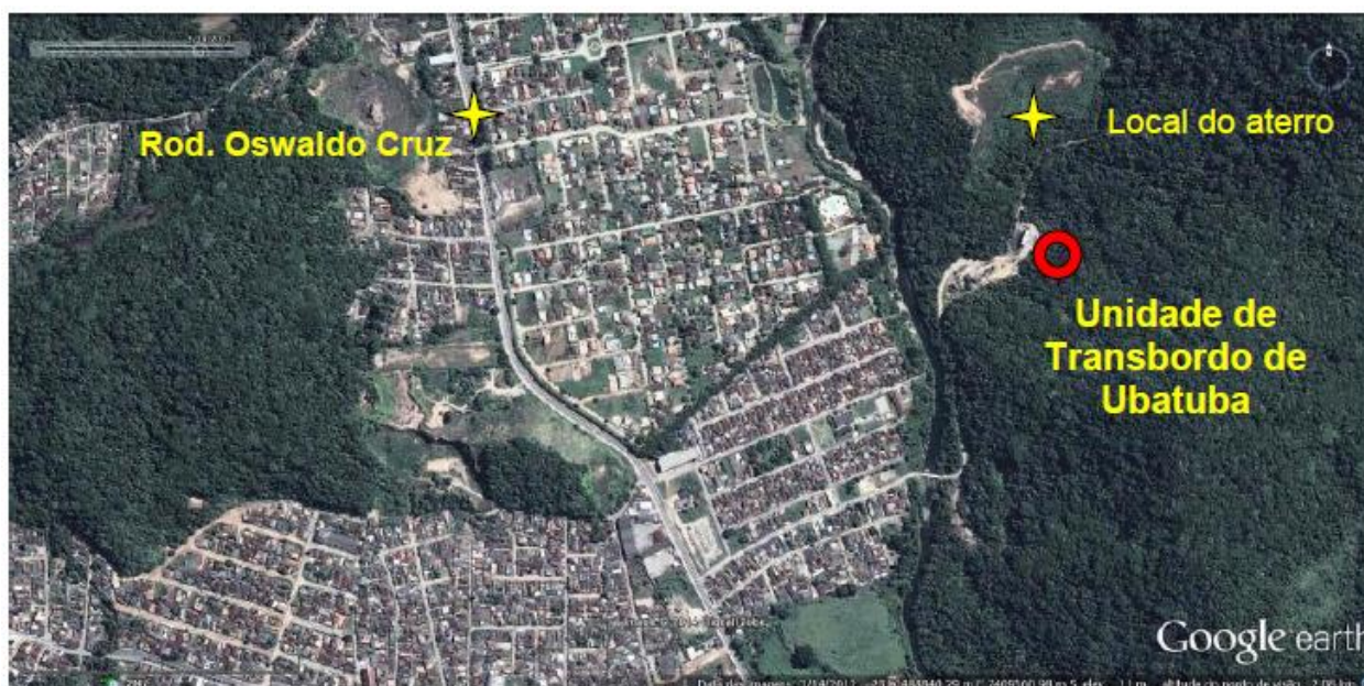
Figura 14 - Vista aérea da unidade de transbordo municipal
