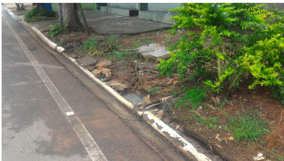
**Foto 3.11 - Rua pavimentada do Distrito Areia Branca, tubulação despejando esgoto diretamente na sarjeta**
