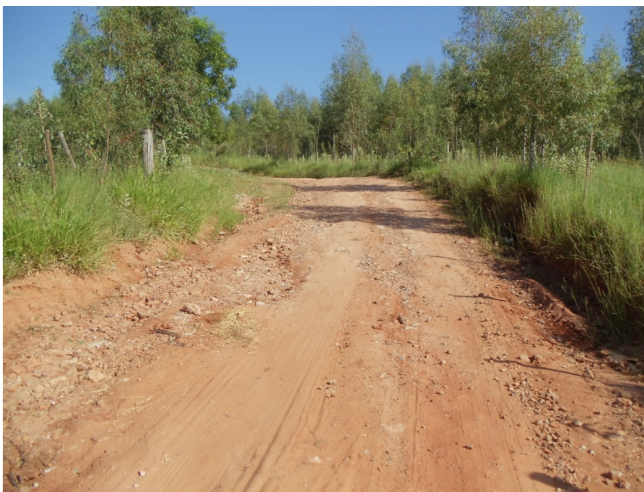
FIGURA 09 – Entulho usado na pavimentação de vicinais. Fonte: GeoArtifex Consultoria & Projetos, 2012.
