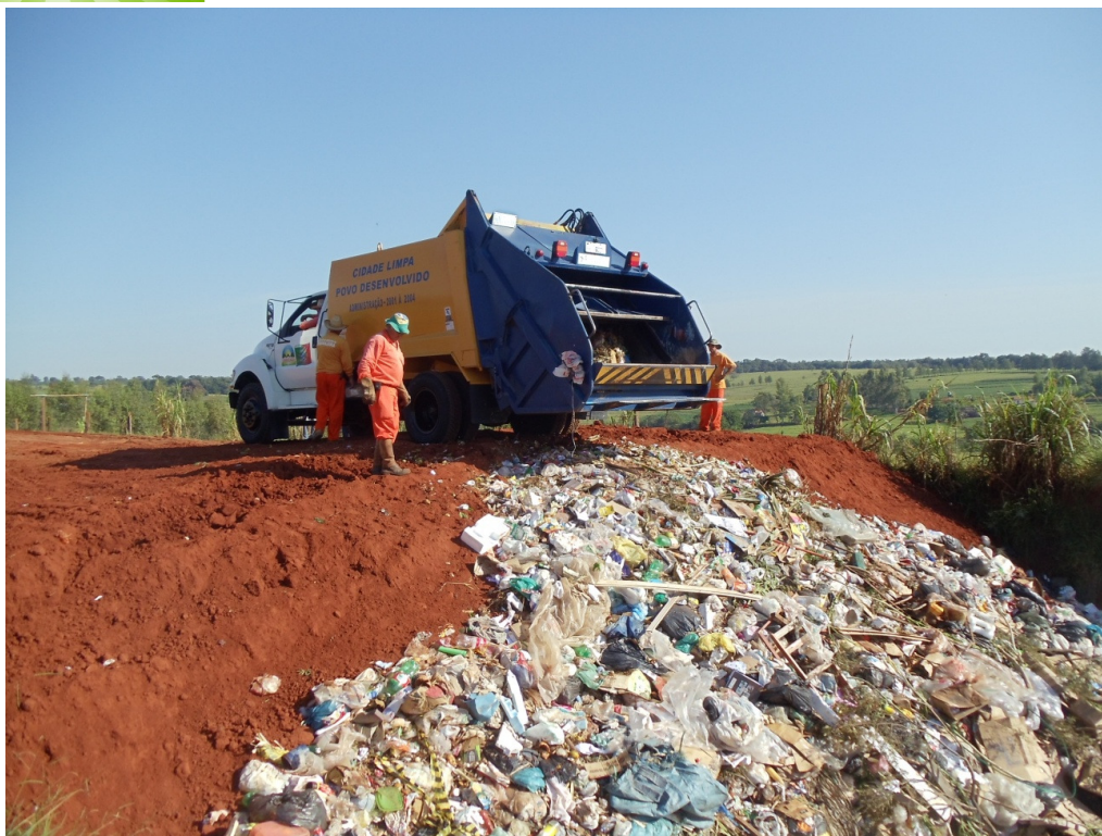
Figura 02 – Aterro em Valas do Município de Ubirajara Fonte: GeoArtifex Consultoria & Projetos, 2012.
