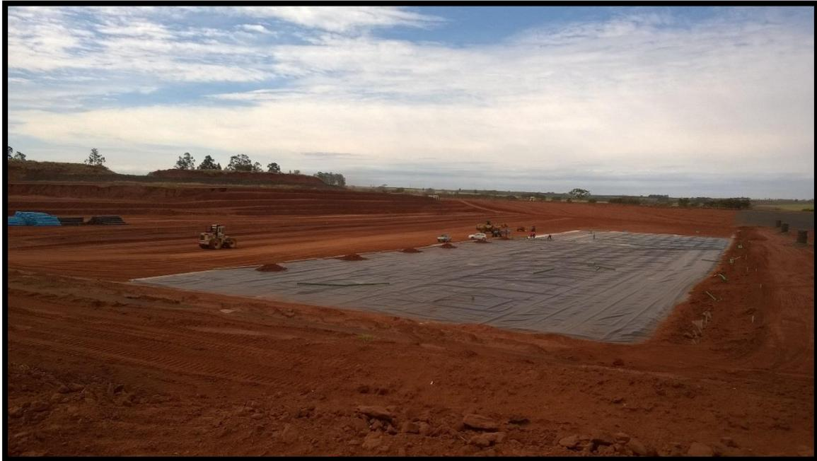
Figura 48 - Preparação de uma vala, com manta impermeabilizante
