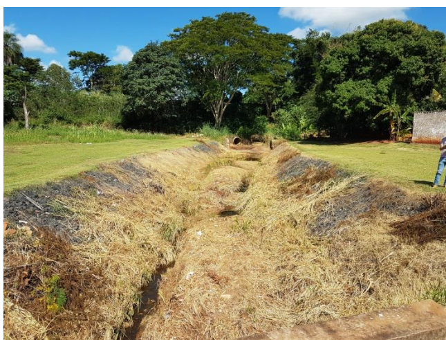
Foto 3.20 – Canal a céu aberto com necessidade de limpeza
