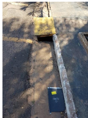
Foto 3.9 – Estrutura de microdrenagem
