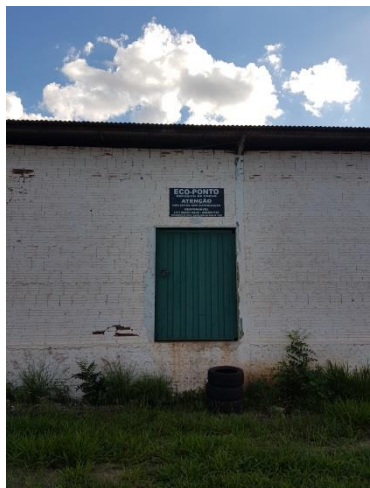
Foto 3.6 – Vista da área de armazenamento de pneus
