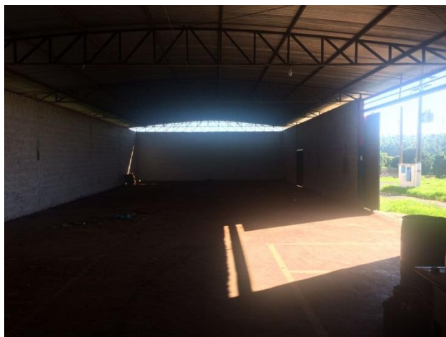
Foto 3.7 - Vista da área de armazenamento de pneus
