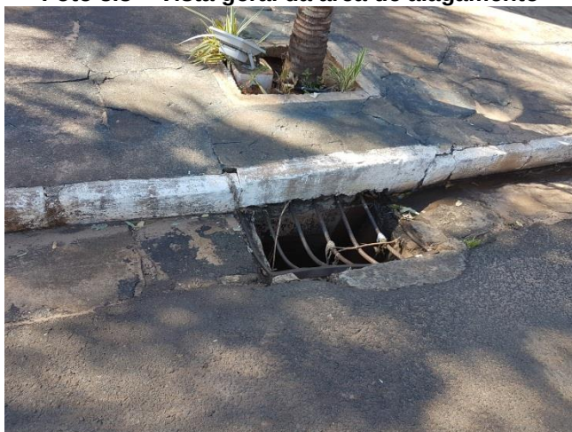
Foto 3.10 – Estrutura de microdrenagem
