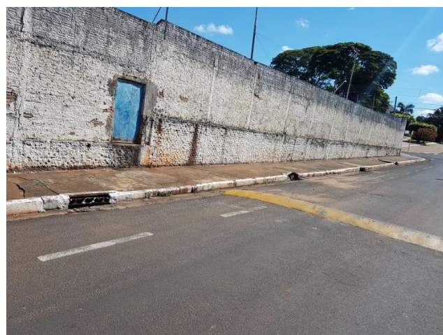
Foto 3.17 – Estrutura de microdrenagem
