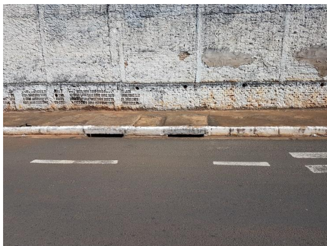
Foto 3.16 – Vista geral da área de alagamento
