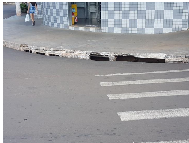
Foto 3.9 – Microdrenagem insuficiente
