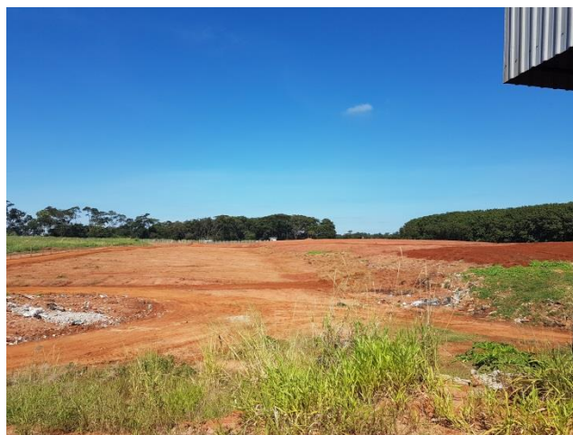
Foto 3.2 - Vista geral – Aterro
