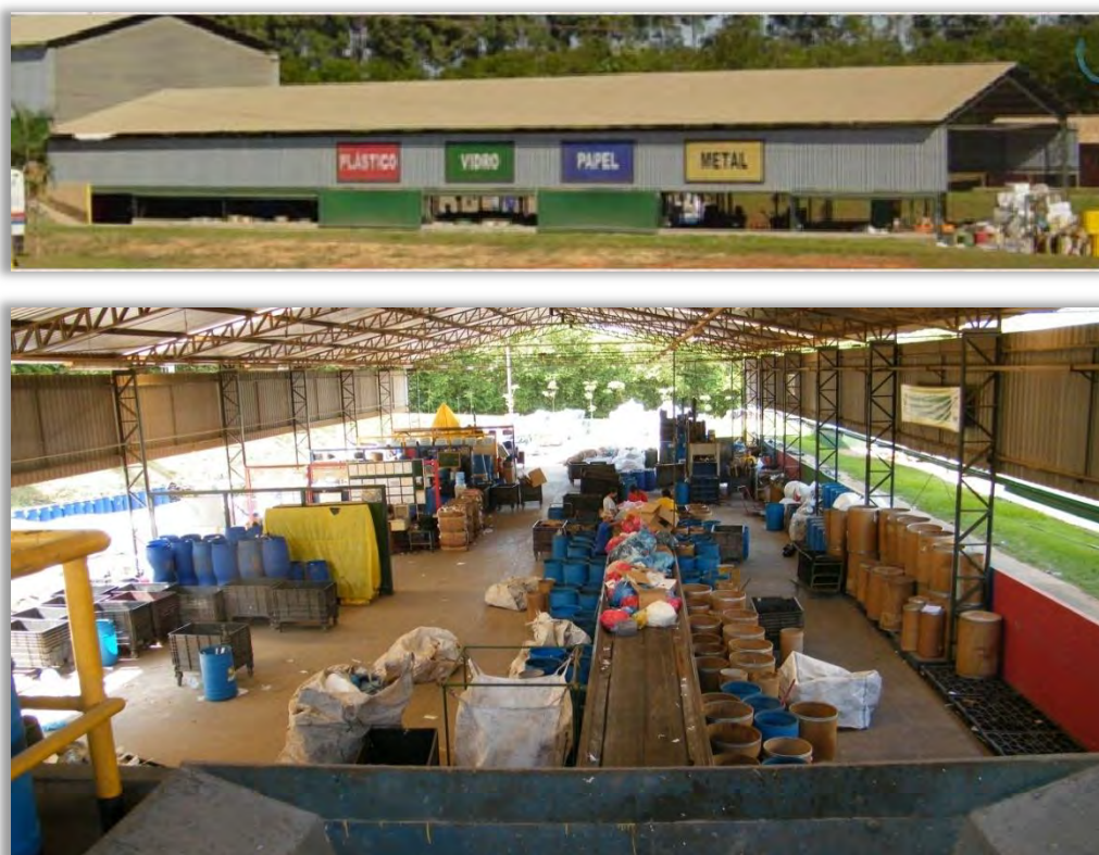
Figura 7.62 – Galpão de triagem da cooperativa Cooperlândia
