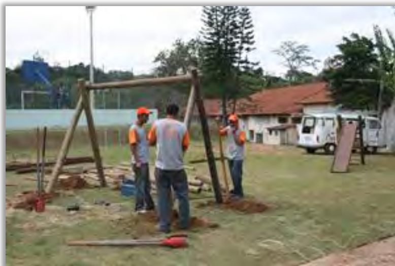
Figura 7.15 – Revitalização de praça
