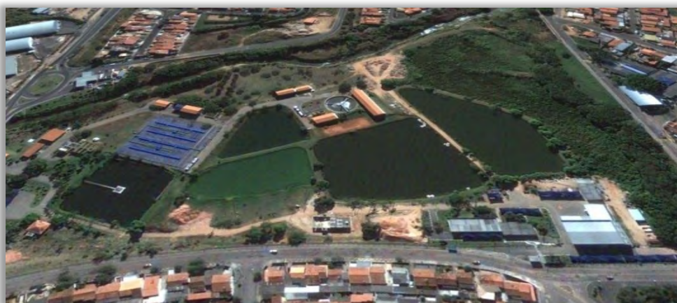
Figura 7.73 – Estação de tratamento de esgoto Capuava.
