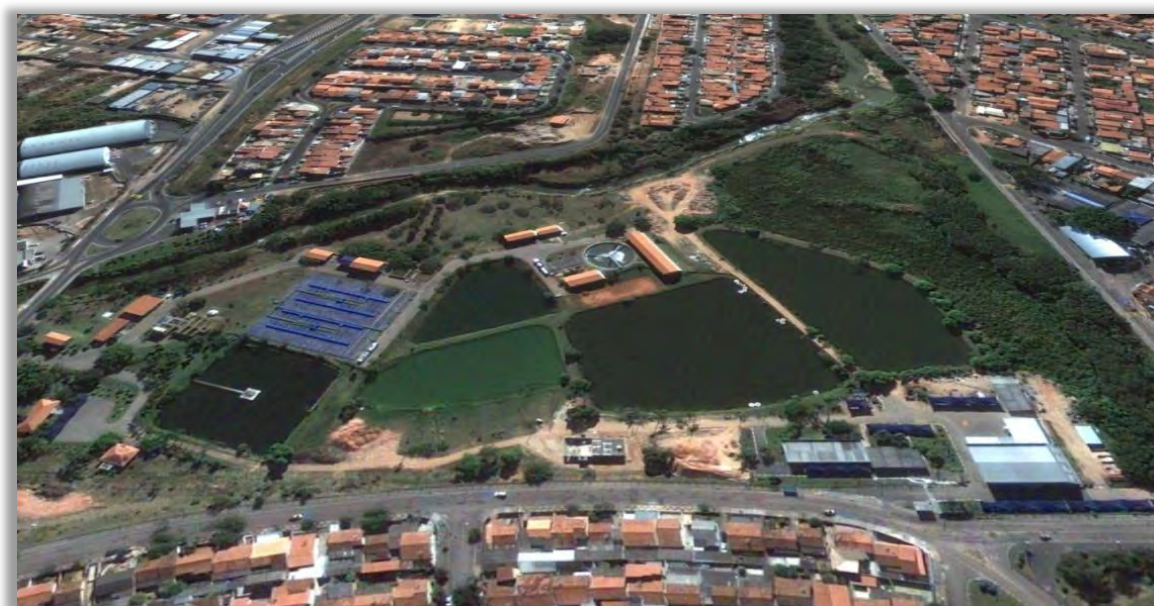
Figura 6.20 – Estação de Tratamento de Esgoto - Capuava.
