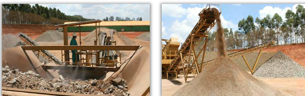
Figura 7.66 - Unidade de Gerenciamento de RCC
