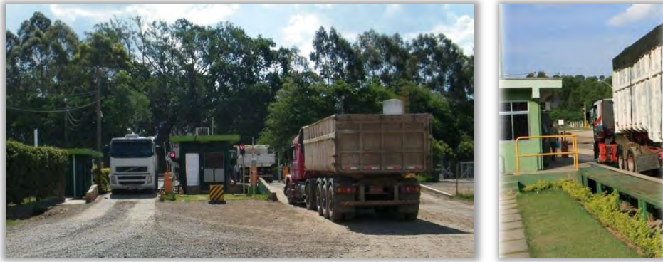
Figura 7.123 - Balança na entrada do Aterro Sanitário
