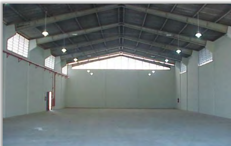
Figura 8.74 – Estrutura pré-fabricada de concreto
