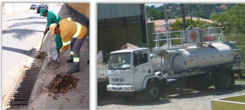
Figura 7.30 – Limpeza de bocas-de-lobo e caminhão hidrojetado
