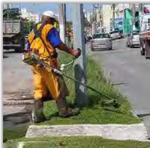
Figura 7.25 – Roçada mecanizada
