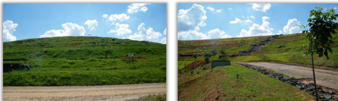
Figura 7.122 – Aterro sanitário ESTRE taludes
