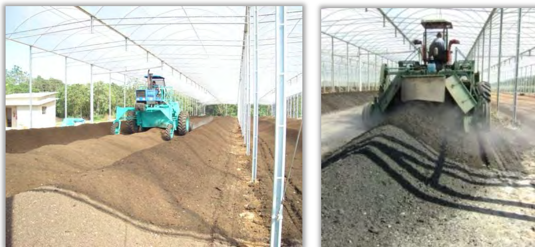
Figura 8.36 - Aplicação de lodo de estação de tratamento e na compostagem
