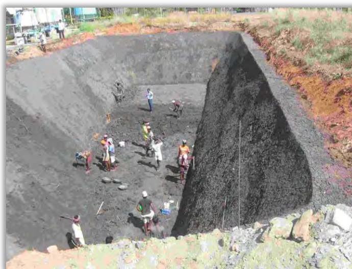
Figura 5.34 – Obra de isolamento do solo para confinamento de material radioativo, Índia.
