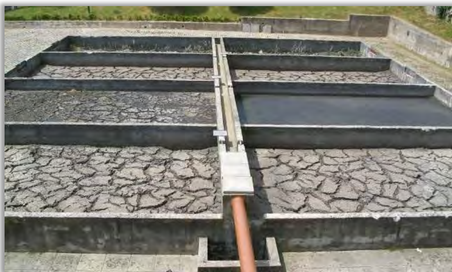
Figura 5.20 – Leito de secagem de lodo de ETA
