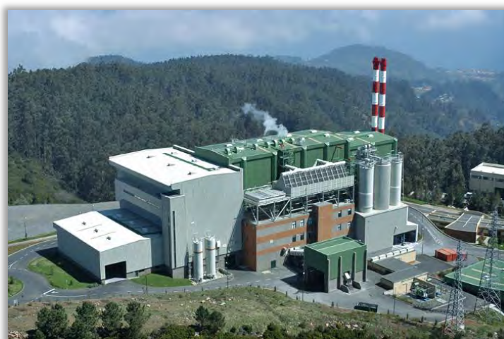
Figura 5.31 – Unidade de incineração situada no Arquipélago das Madeiras, em Portugal.
