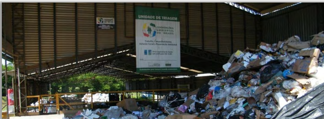
Figura 7.124 – Unidade de triagem de recicláveis cooperativa COOPERLÂNDIA
