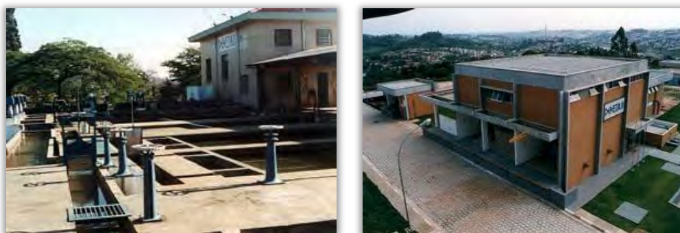
Figura 6.19 – ETA I e ETA II. Fonte: DAEV.
