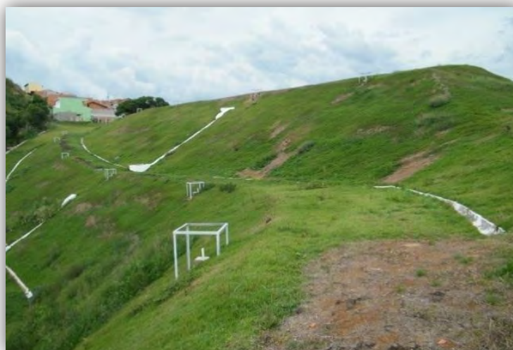
Figura 7.115 – Aterro de inertes encerrado
