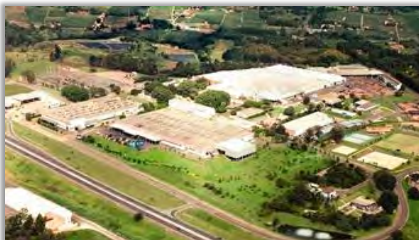
Figura 7.83 – Instalações da Eaton em Valinhos
