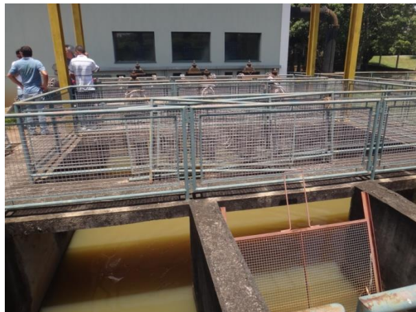
Foto 4.2 – Tomada de Água na Captação
