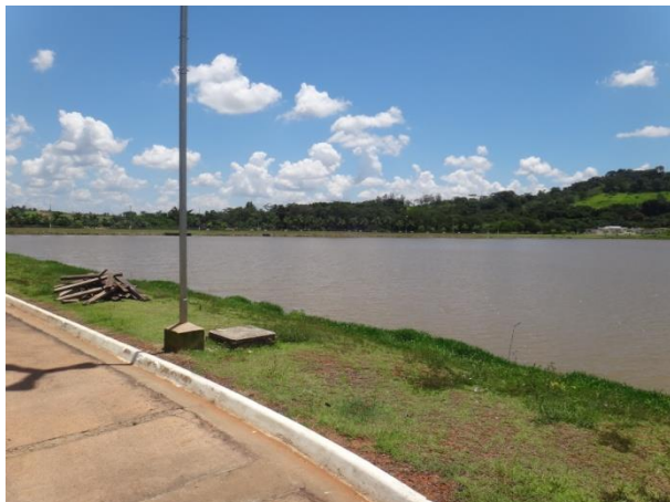
Foto 4.1 – Vista Geral da Represa do Rio Verde
