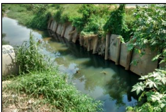
Figura 176 - Execução de vias nas margens do córrego Bertioga sem a devida manutenção com depósitos de entulhos de construção comprometendo a seção da travessia.
