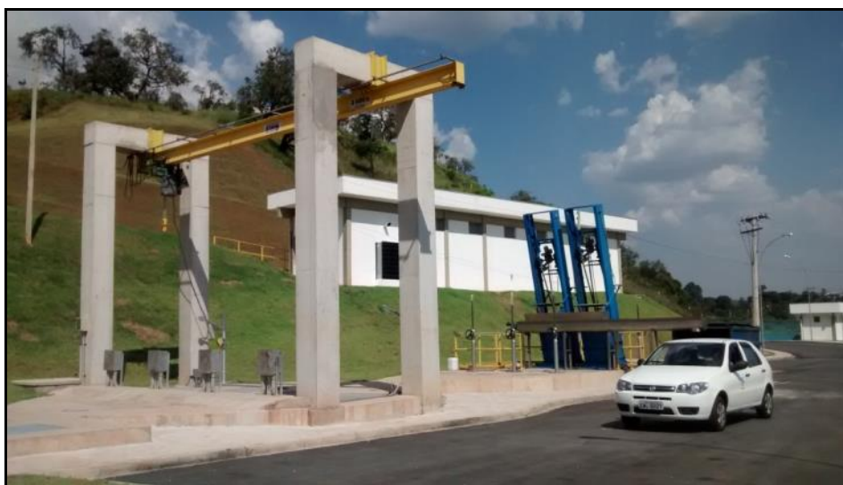
Figura 120 - Vistas da área externa da EEB Final (entrada da ETE Várzea Paulista).
