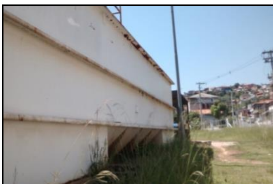
Figura 59 - Vista da lateral do módulo de decantação desativado e do topo da laje do reservatório completamente alagada devido aos vazamentos existentes no local.
