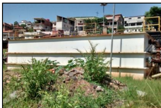
Figura 58 - Vista do reservatório com vazamento expressivo de água e do módulo de decantação desativado.
