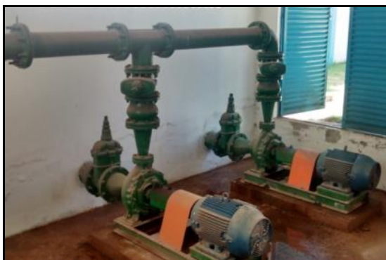
Figura 71 - ETA Palmeiras: a) painel de comando; b) sistema de bombeamento.
