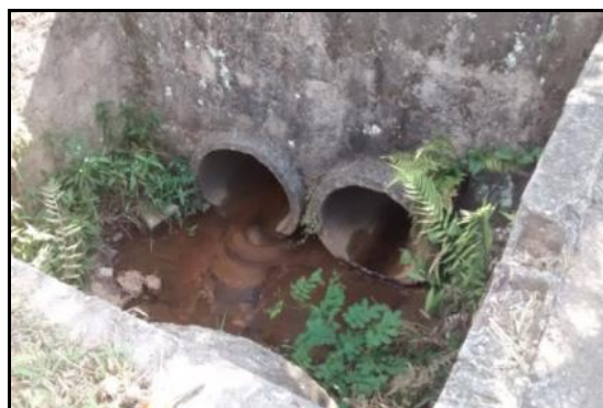
Figura 34 - Vista Caixa de descarte do excesso de água da represa do Clube de Campo.
