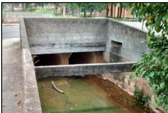
Figura 185 - Trecho canalizado do Córrego Pinheirinho com problemas de crescimento de vegetação e pontos de rachaduras no fundo de concreto.
