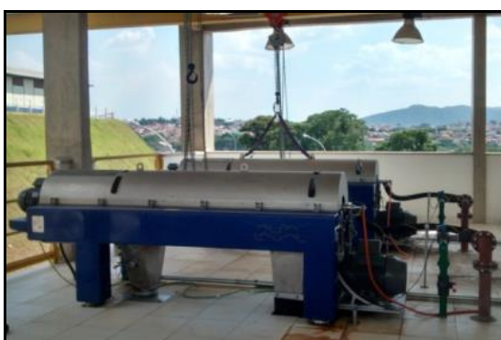
Figura 140 - Vista das Centrífugas e dos painéis de controle de Centrífugas e Adensadores Mecanizados.
