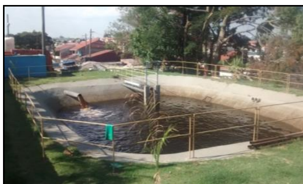
Figura 49 - Bombas dosadoras de produtos químicos e tanque de água de lavagem dos filtros, de onde a água retorna para o processo de tratamento.
