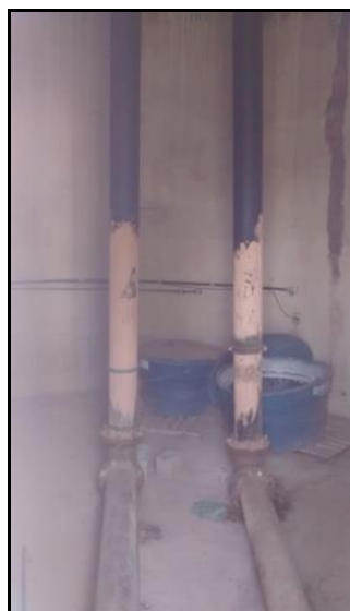
Figura 90 - Vistas do reservatório do Jardim Diana apresentando as tubulações de alimentação e saída.
