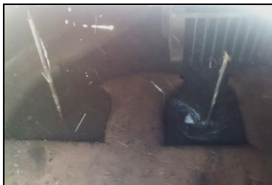
Figura 123 - Vistas da área externa do Sifão Invertido e de seu interior identificando a grade grosseira.
