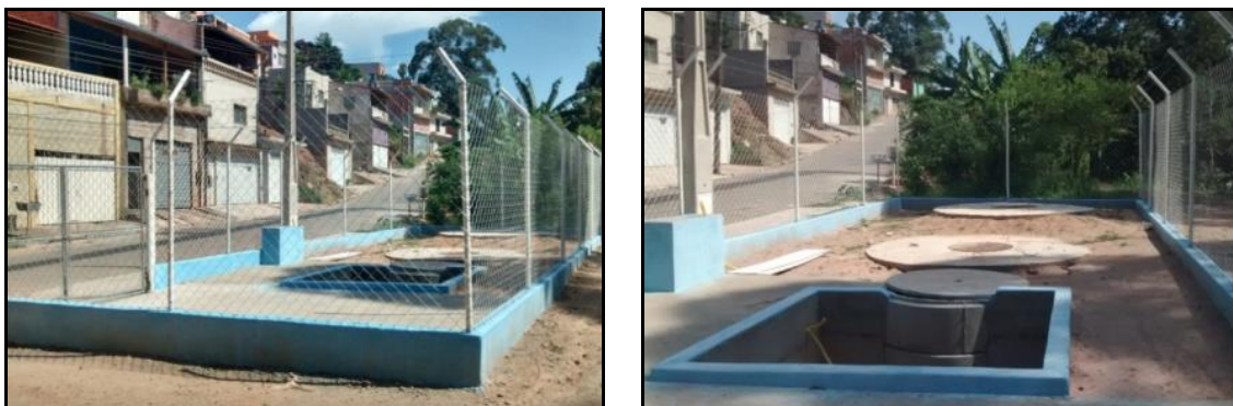
Figura 119 - Vistas da área externa da EEEB Bahia I em fase final de construção.
