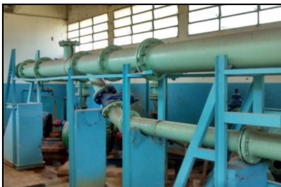
Figura 32 - Interior da EEAB com as tubulações e sistemas de bombeamento.
