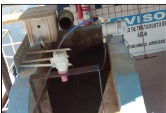
Figura 43 - Chegada de água bruta na calha Parshall e medidor ultrassônico de nível.
