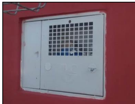
Figura 110 - Cavalete e caixa padrão SABESP para os hidrômetros.
