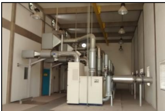
Figura 138 - Interior do Prédio dos Sopradores e tubulação de oxigênio que segue para os Tanques de Aeração.
