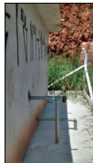
Figura 75 - Sistema de bombeamento e tubulações de sucção e recalque da EEAT.
