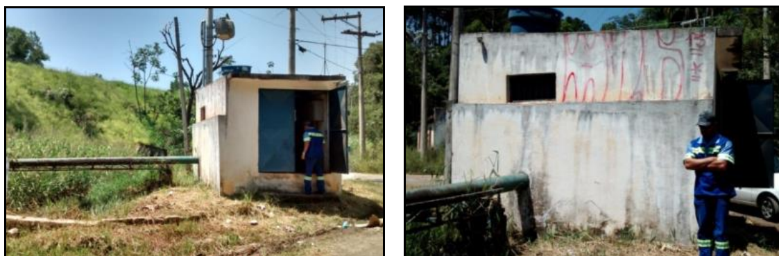
Figura 18 - Vistas do local da captação do Córrego Moinho identificando o abrigo da bomba de sucção.
