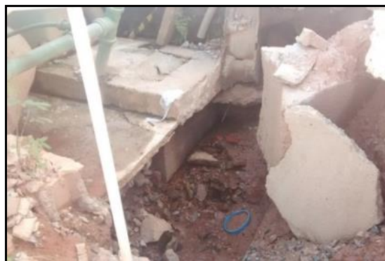
Figura 51 - Saída da água tratada e local sendo demolido para detecção de vazamento de água.
