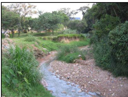
Figura 193 - Observam-se as margens desprotegidas e o leito do córrego assoreado.
