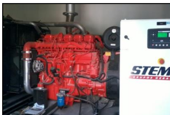
Figura 116 - Vistas do interior da EEEB Olívio Moura – gerador de energia a diesel.
