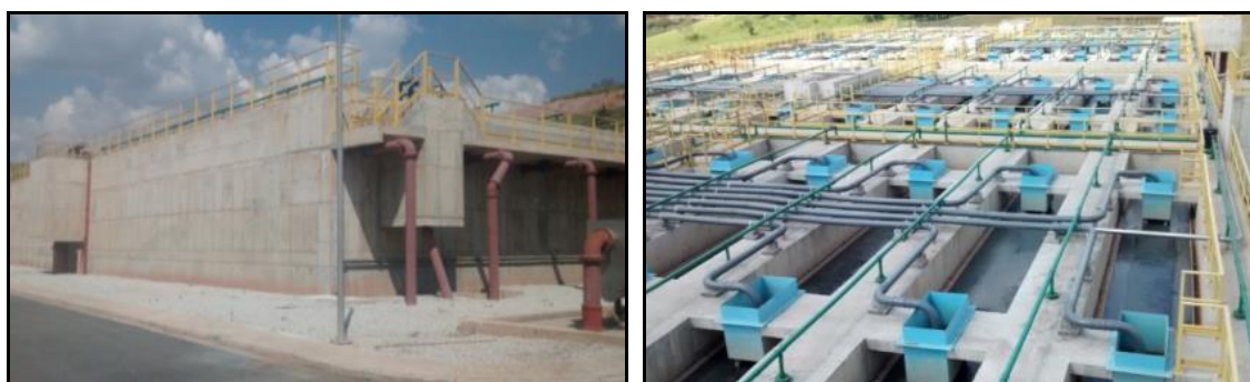
Figura 134 - Vista lateral e superior dos Reatores UASB.
