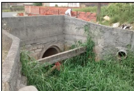
Figura 184 - Final do trecho do Córrego Pinheirinho em canal natural com falta de manutenção e travessia com tubulação insuficiente que compromete o escoamento da água no córrego.
