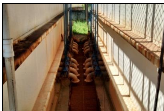
Figura 60 - Vista das tubulações da ETA desativada e da calha de descarga de fundo dos decantadores.
