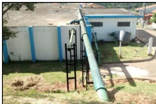
Figura 86 - Adução de água tratada e vista geral dos reservatórios da ETA Palmeiras.
