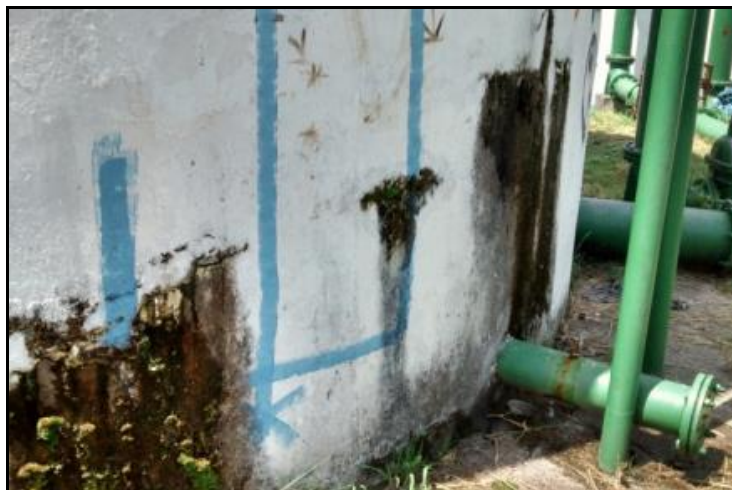
Figura 106 - Tubulações de saída e elevatória existente na área dos reservatórios do Ilerê.
