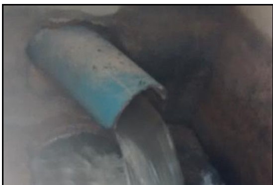
Figura 26 - Vista do interior da caixa de captação do Córrego Pinheirinho de onde sai a tubulação que abastece a lagoa do Clube de Campo.
