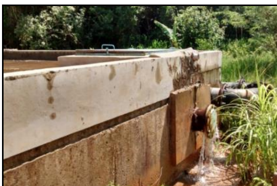
Figura 58 - Vista do reservatório com vazamento expressivo de água e do módulo de decantação desativado.
