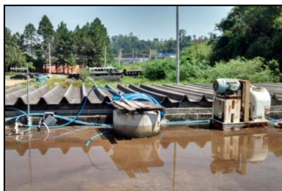
Figura 59 - Vista da lateral do módulo de decantação desativado e do topo da laje do reservatório completamente alagada devido aos vazamentos existentes no local.
