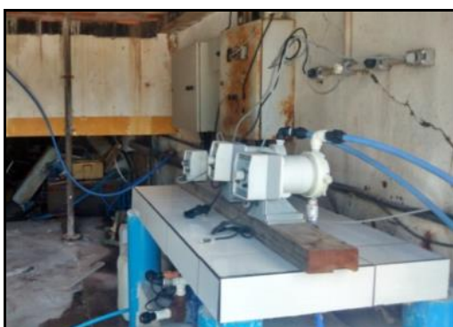
Figura 49 - Bombas dosadoras de produtos químicos e tanque de água de lavagem dos filtros, de onde a água retorna para o processo de tratamento.
