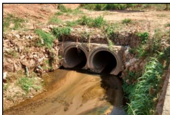
Figura 175 - Taludes sem proteção ocasionando assoreamento e comprometendo a seção hidráulica das travessias.
