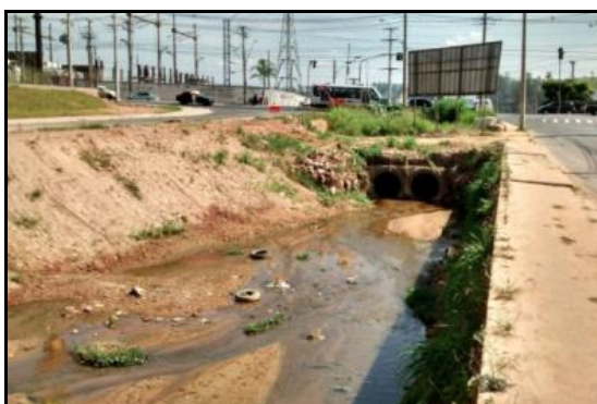
Figura 175 - Taludes sem proteção ocasionando assoreamento e comprometendo a seção hidráulica das travessias.
