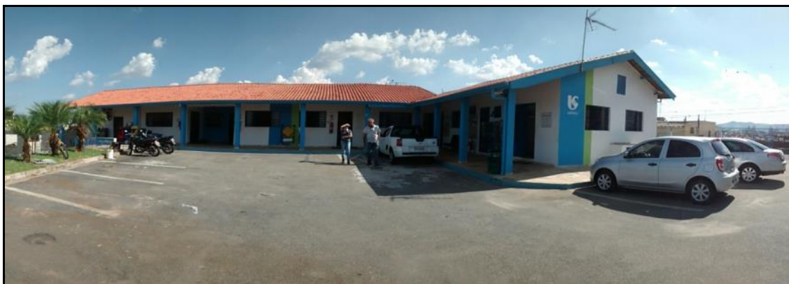
Figura 38 - Vista geral da área dos prédios administrativos da ETA Palmeiras e Sede da SABESP.
