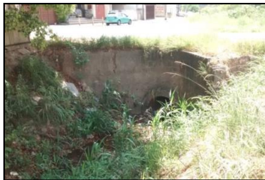
Figura 183 - Trechos da parcela do Córrego Pinheirinho coberto por vegetação e travessia obstruída pela vegetação.
