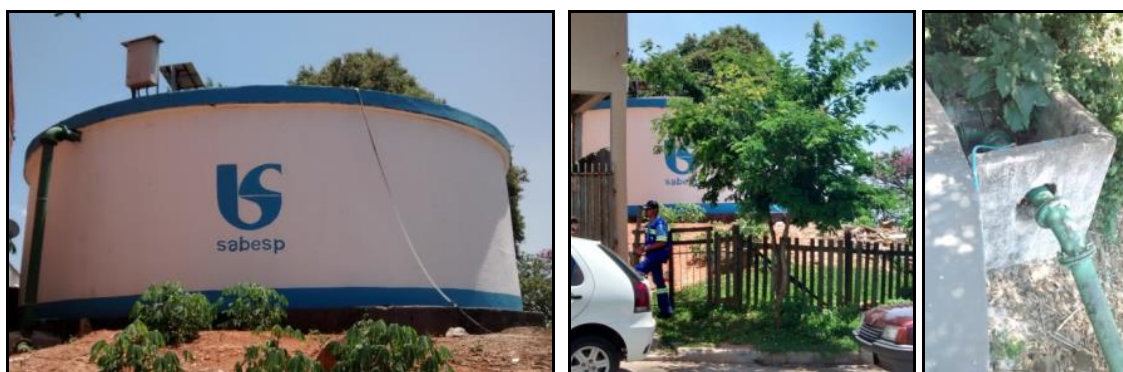
Figura 97 - Vistas do reservatório Manacá e detalhe da saída para alimentação do bairro.
