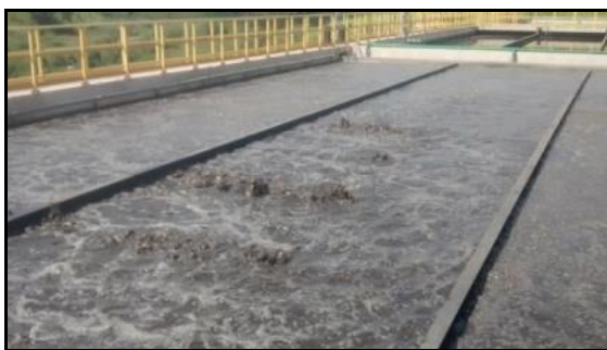
Figura 136 - Tanque de aeração em funcionamento com a difusão de oxigênio e em ambiente anóxico para realização da remoção de nutrientes do esgoto em tratamento.
