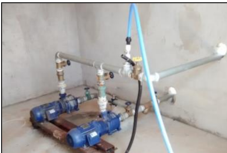
Figura 75 - Sistema de bombeamento e tubulações de sucção e recalque da EEAT.
