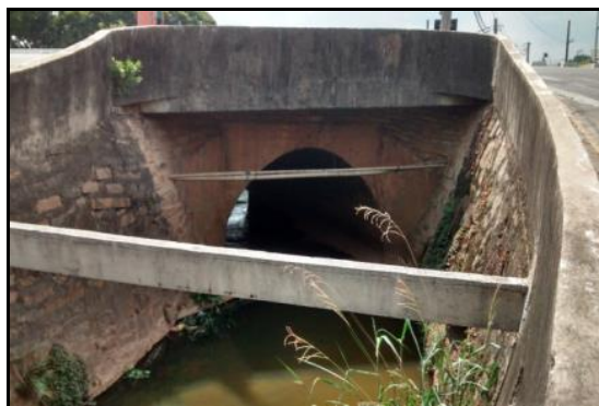
Figura 186 - Trecho canalizado do Córrego Pinheirinho com problemas de crescimento de vegetação e travessia com seção insuficiente.
