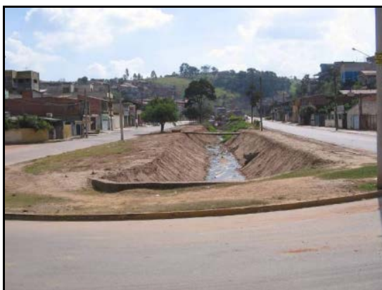
Figura 194 - Observam-se as travessias assoreadas e canal com margens desprotegidas.
