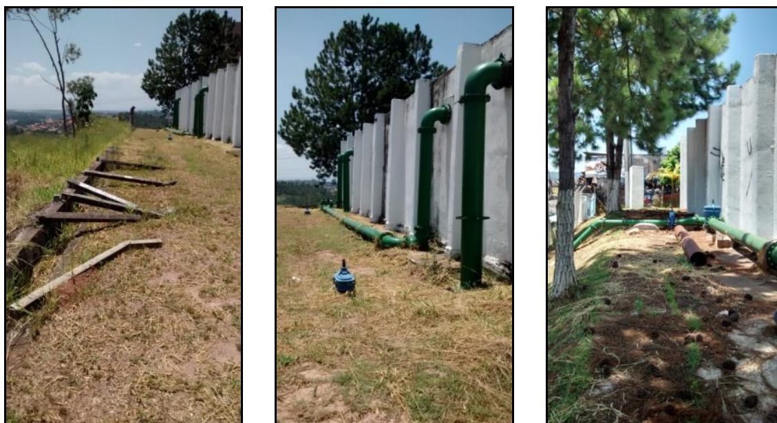
Figura 100 - Vista externa do reservatório Tanque Velho.
