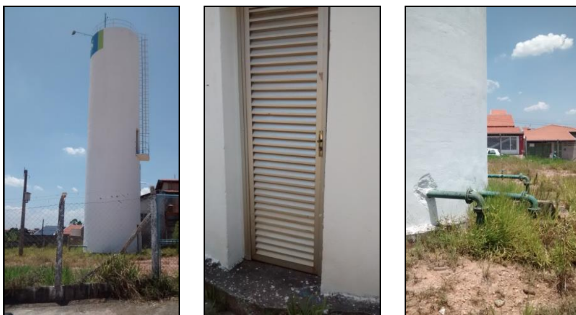
Figura 101 – Vistas do reservatório Itália I.
