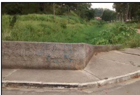
Figura 184 - Final do trecho do Córrego Pinheirinho em canal natural com falta de manutenção e travessia com tubulação insuficiente que compromete o escoamento da água no córrego.
