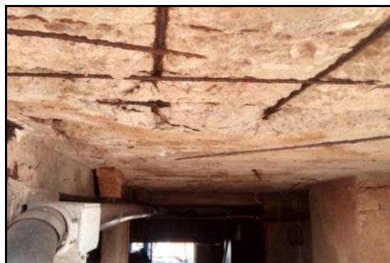
Figura 50 - Passagem de tubulações e válvulas sob o laboratório da ETA com laje corroída e armaduras expostas.
