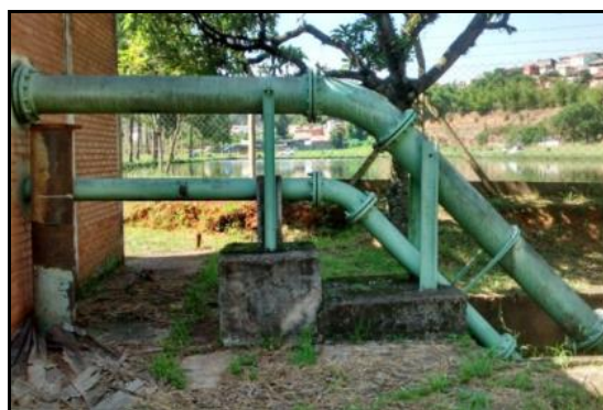
Figura 31 - Vistas da Estação Elevatória de Água Bruta Clube de Campo e das tubulações de recalque e de sucção.
