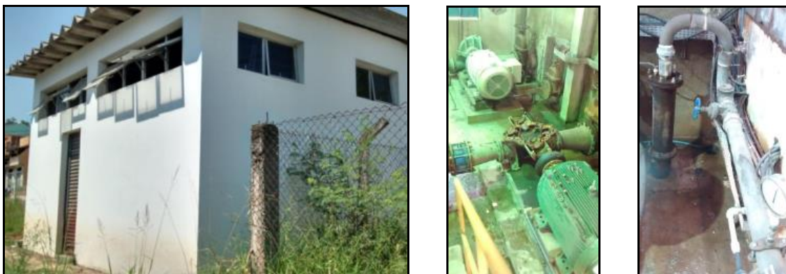
Figura 64 - Vista geral da entrada da EEAT Felicidade, do interior da casa de bombas e da bomba axial responsável pelo abastecimento do Reservatório das Flores.
