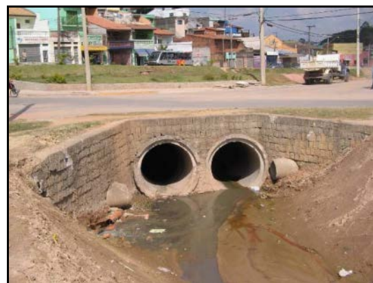
Figura 194 - Observam-se as travessias assoreadas e canal com margens desprotegidas.
