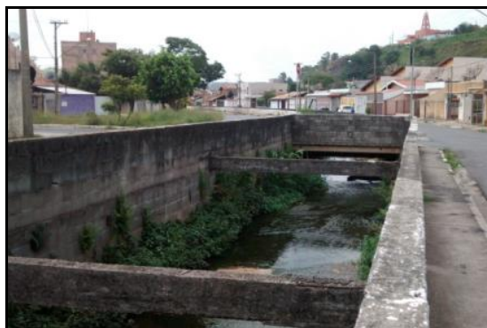
Figura 185 - Trecho canalizado do Córrego Pinheirinho com problemas de crescimento de vegetação e pontos de rachaduras no fundo de concreto.
