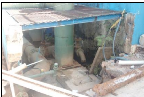
Figura 51 - Saída da água tratada e local sendo demolido para detecção de vazamento de água.
