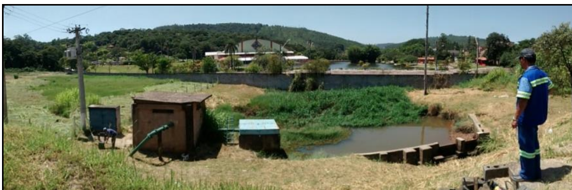
Figura 21 - Vista geral da captação junto ao Córrego Guapeva.
