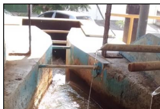
Figura 43 - Chegada de água bruta na calha Parshall e medidor ultrassônico de nível.
