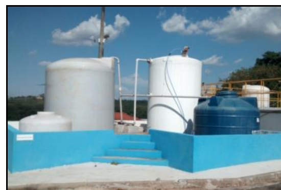
Figura 48 - Saída dos filtros e tanques de produtos químicos utilizados no processo de tratamento.
