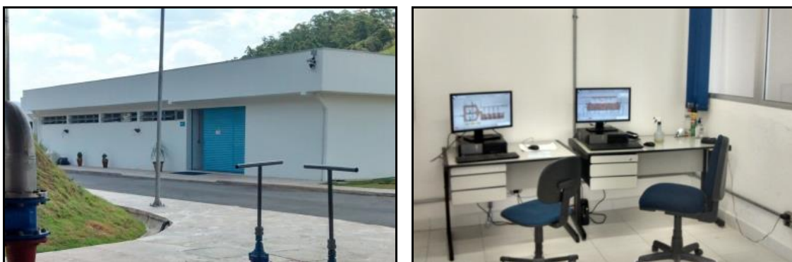
Figura 127 - Vistas externas e internas do Prédio de Administração e Laboratório da ETE.
