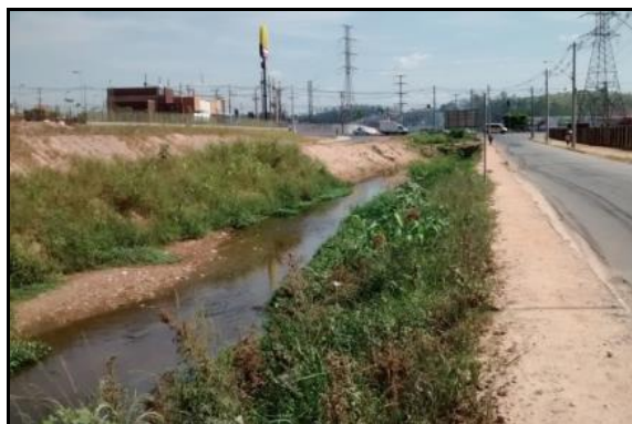
Figura 174 - Calha do Córrego Bertioga com falta de manutenção e trecho com baixa declividade no qual frequentemente observam-se extravasamentos e consequentes alagamentos nas vias marginais.
