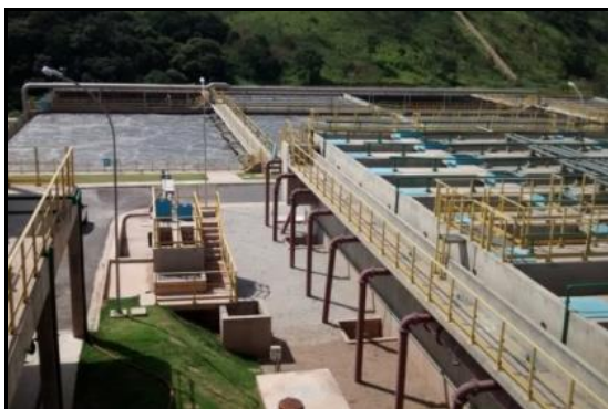
Figura 135 - Vista geral dos Reatores UASB e dos Tanques de Aeração intermitente.
