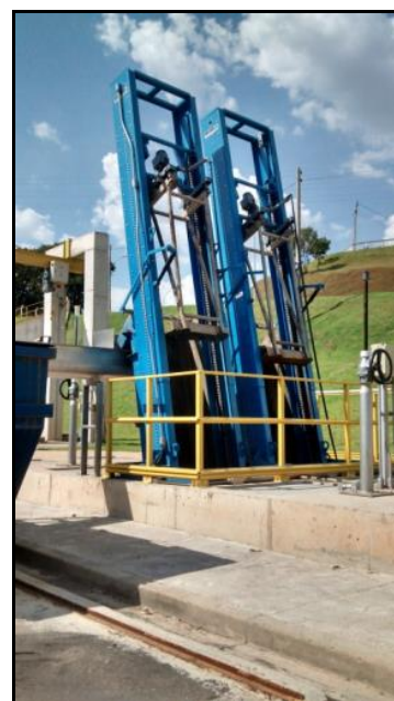
Figura 121 - Vistas da área externa da EEB Final e sua grade cremalheira automatizada.
