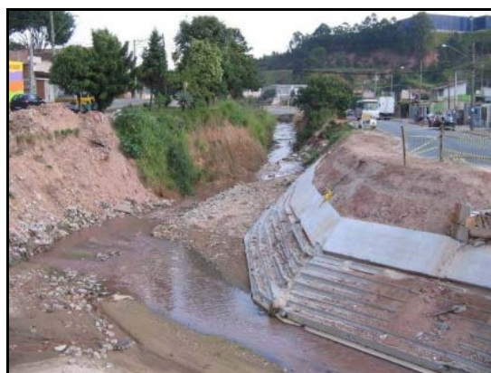
Figura 193 - Observam-se as margens desprotegidas e o leito do córrego assoreado.
