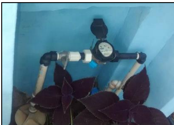
Figura 110 - Cavalete e caixa padrão SABESP para os hidrômetros.
