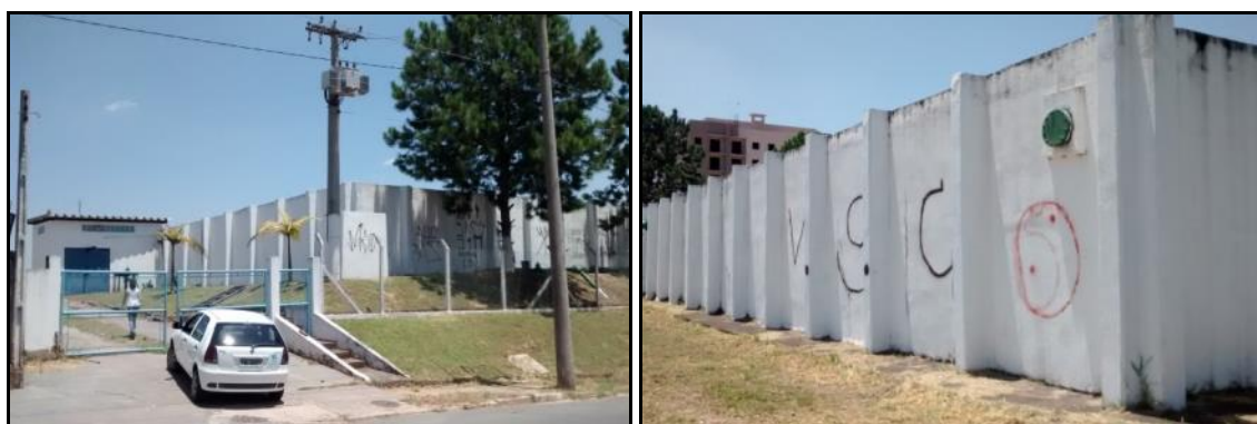
Figura 99 - Vistas do reservatório Tanque Velho.
