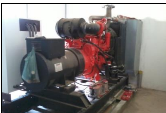
Figura 116 - Vistas do interior da EEEB Olívio Moura – gerador de energia a diesel.
