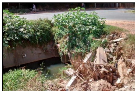
Figura 176 - Execução de vias nas margens do córrego Bertioga sem a devida manutenção com depósitos de entulhos de construção comprometendo a seção da travessia.
