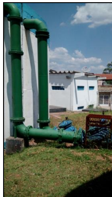
Figura 106 - Tubulações de saída e elevatória existente na área dos reservatórios do Ilerê.
