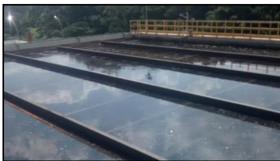
Figura 136 - Tanque de aeração em funcionamento com a difusão de oxigênio e em ambiente anóxico para realização da remoção de nutrientes do esgoto em tratamento.
