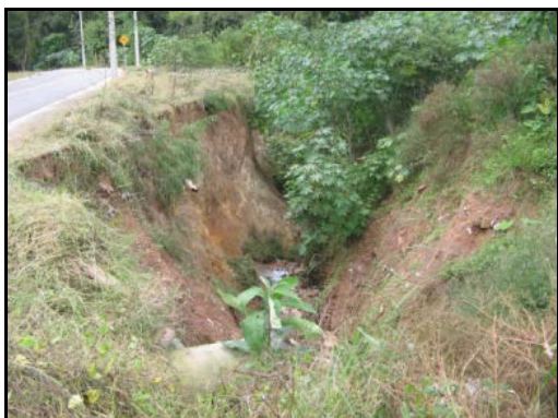
Figura 174 - Calha do Córrego Bertioga com falta de manutenção e trecho com baixa declividade no qual frequentemente observam-se extravasamentos e consequentes alagamentos nas vias marginais.
