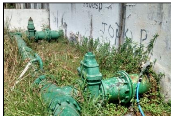
Figura 92 - Vistas do reservatório Promeca desativado, do booster Promeca e das tubulações de saída dos reservatórios principais (2.000 m 3 cada).
