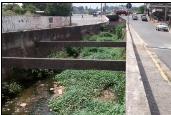
Figura 186 - Trecho canalizado do Córrego Pinheirinho com problemas de crescimento de vegetação e travessia com seção insuficiente.
