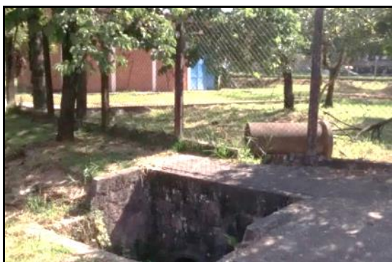
Figura 34 - Vista Caixa de descarte do excesso de água da represa do Clube de Campo.
