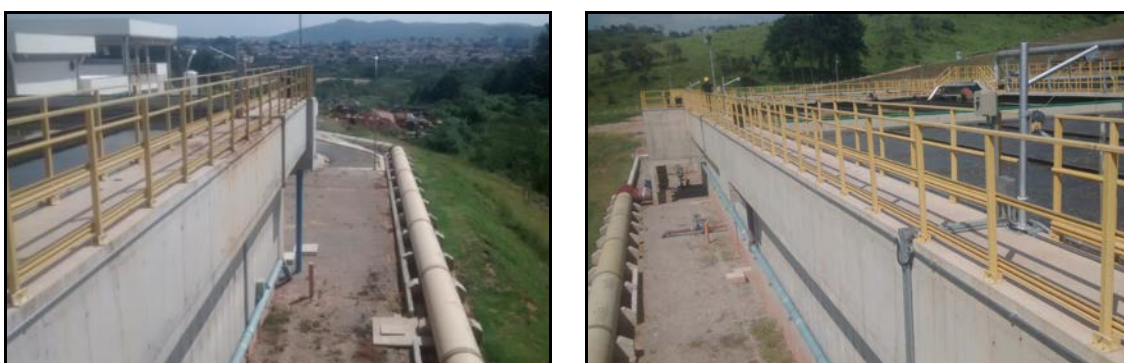
Figura 141 - Vistas das tubulações de coleta e emissário final do esgoto tratado na ETE.
