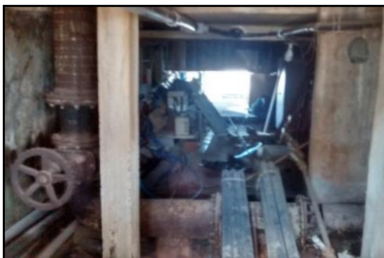
Figura 50 - Passagem de tubulações e válvulas sob o laboratório da ETA com laje corroída e armaduras expostas.
