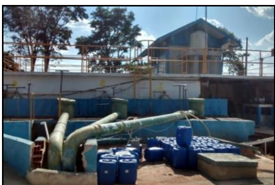
Figura 48 - Saída dos filtros e tanques de produtos químicos utilizados no processo de tratamento.
