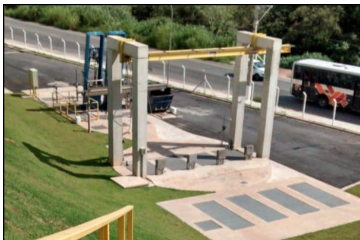
Figura 121 - Vistas da área externa da EEB Final e sua grade cremalheira automatizada.
