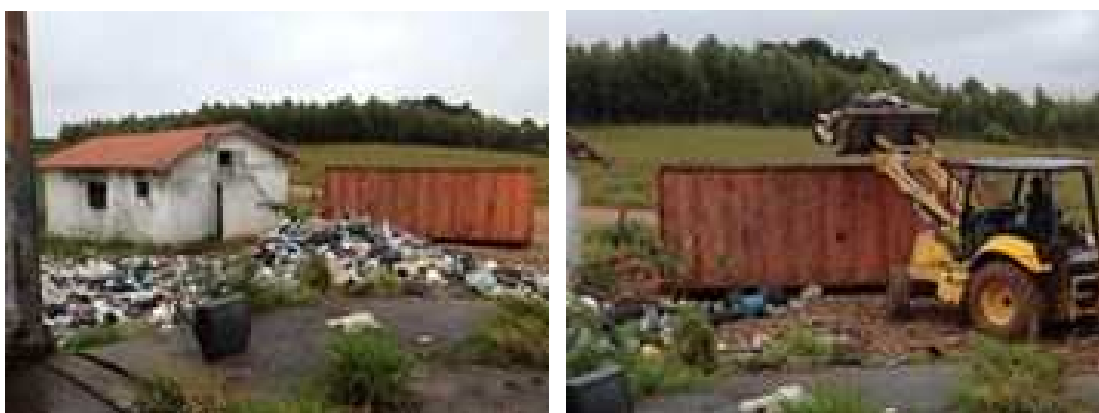
Figura 2. Procedimento de transbordo de resíduos no Aterro de Vera Cruz
