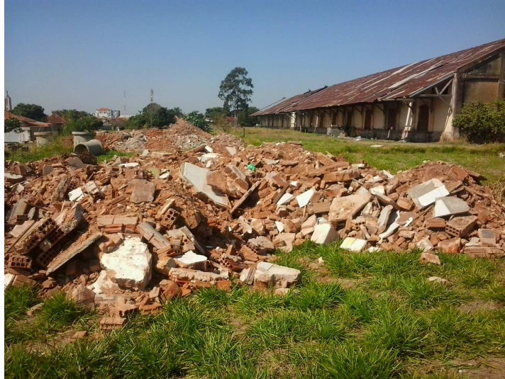
Figura 19. Área de armazenamento de RCC, próxima à antiga estação ferroviária
