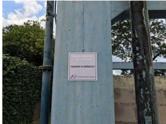
Figura 151. Vista da placa de identificação do reservatório.
