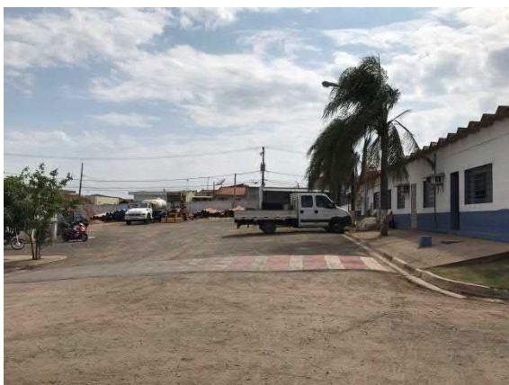
Figura 74. Vista do pátio de manobras da ETA I.
