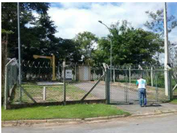
Figura 168. Estação Elevatória de Esgoto – Barra do Saí (Marambaia) - Vista 1.
