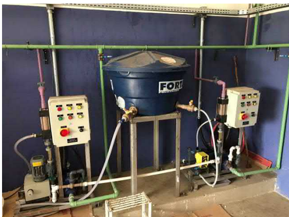
Figura 72. Vista do sistema dosador de polímero.
