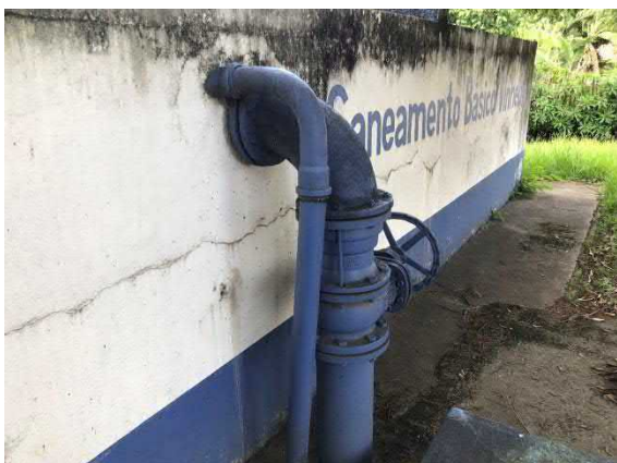
Figura 144. Vista da entrada de água no reservatório.
