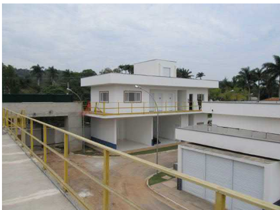
Figura 84. Vista geral da ETA III.
