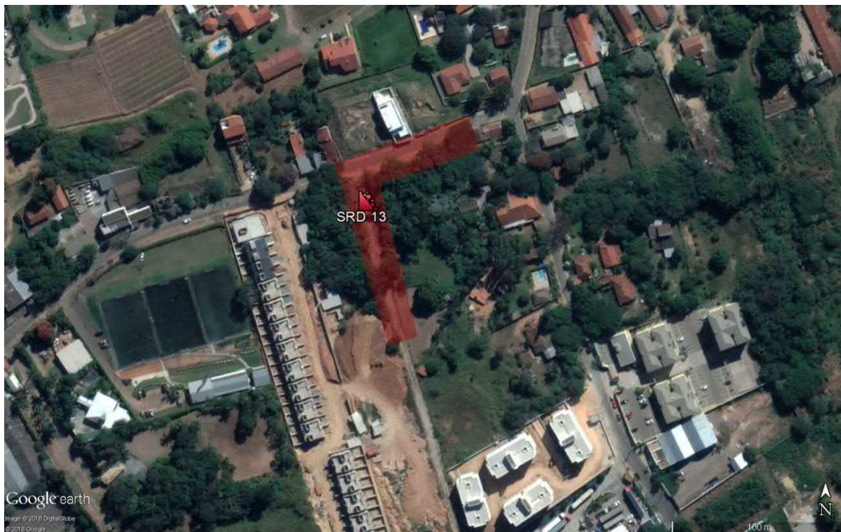
Figura 205. Área de Risco SRD 13 - Rua Antônio Ferragut, Pinheiro.
