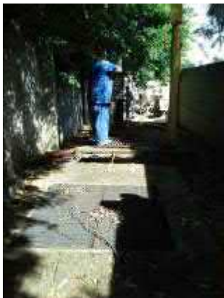
Figura 160. Estação Elevatória - Vida Nova III - Vista 1.
