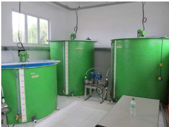
Figura 94. Vista da sala de química.
