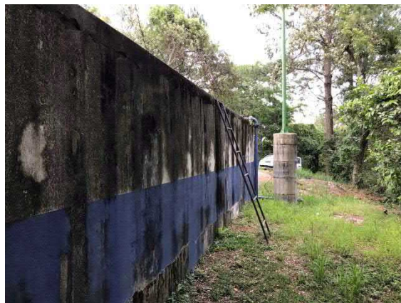
Figura 136. Vista do acesso a laje de cobertura do reservatório.
