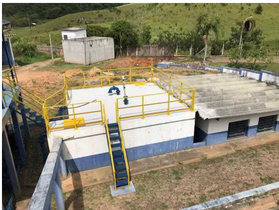
Figura 146. Vista do reservatório apoiado de 90m 3 .
