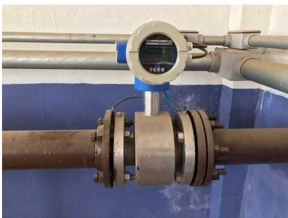
Figura 70. Vista do macromedidor de vazão, instalado na linha de recalque.
