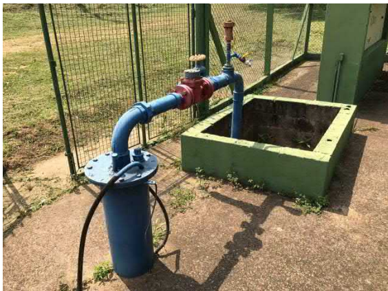
Figura 96. Vista geral do poço.
