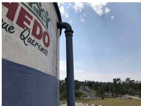
Figura 118. Vista do extravasor do reservatório.
