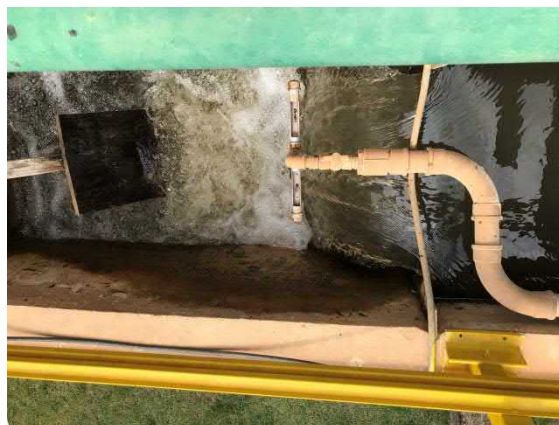
Figura 79. Vista do resalto hidráulico no vertedor e aplicação de coagulante.
