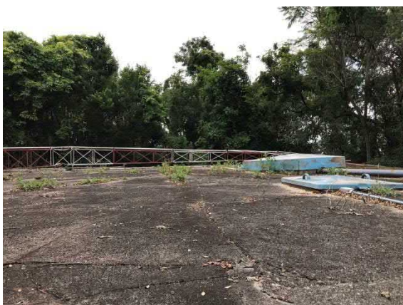
Figura 137. Vista da laje de cobertura.
