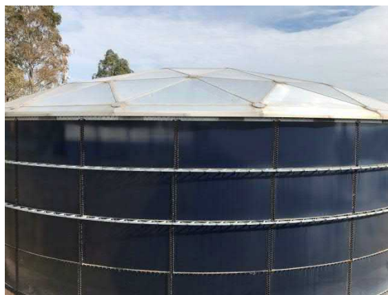
Figura 122. Vista do reservatório de 2.000m³.
