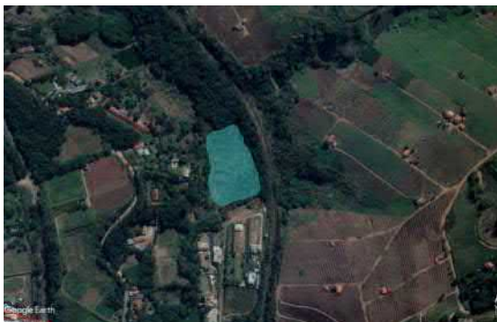
Figura 262. Vista do local da Represa nº 6.
