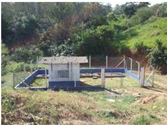
Figura 166. Estação Elevatória de Esgoto – Casa Verde - Vista 1.
