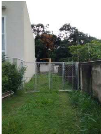
Figura 176. Estação Elevatória de Esgoto – Treviso - Vista 1.
