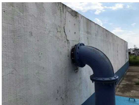
Figura 140. Vista da saída do reservatório.
