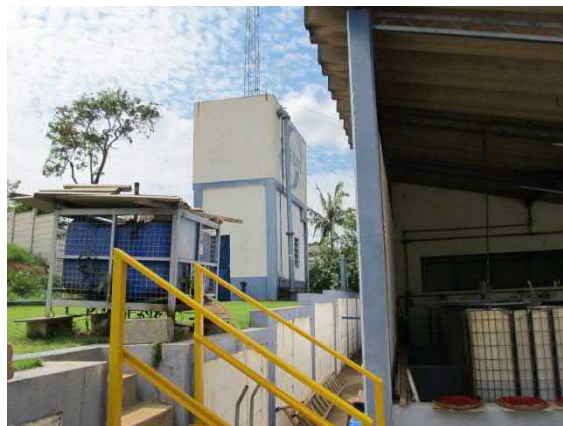
Figura 147. Vista do reservatório elevado de 30m 3 .
