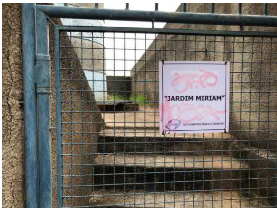
Figura 131. Vista da entrada do reservatório.
