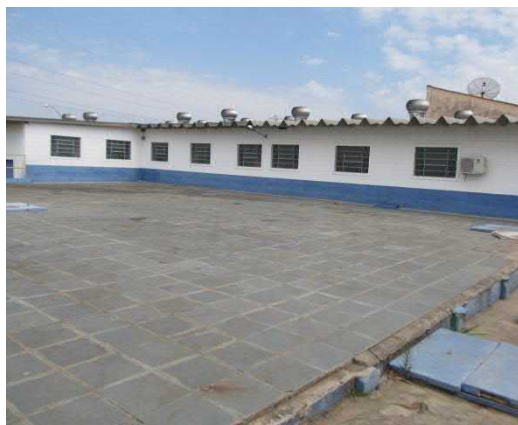
Figura 124. Vista do reservatório semi enterrado de 600m 3 .
