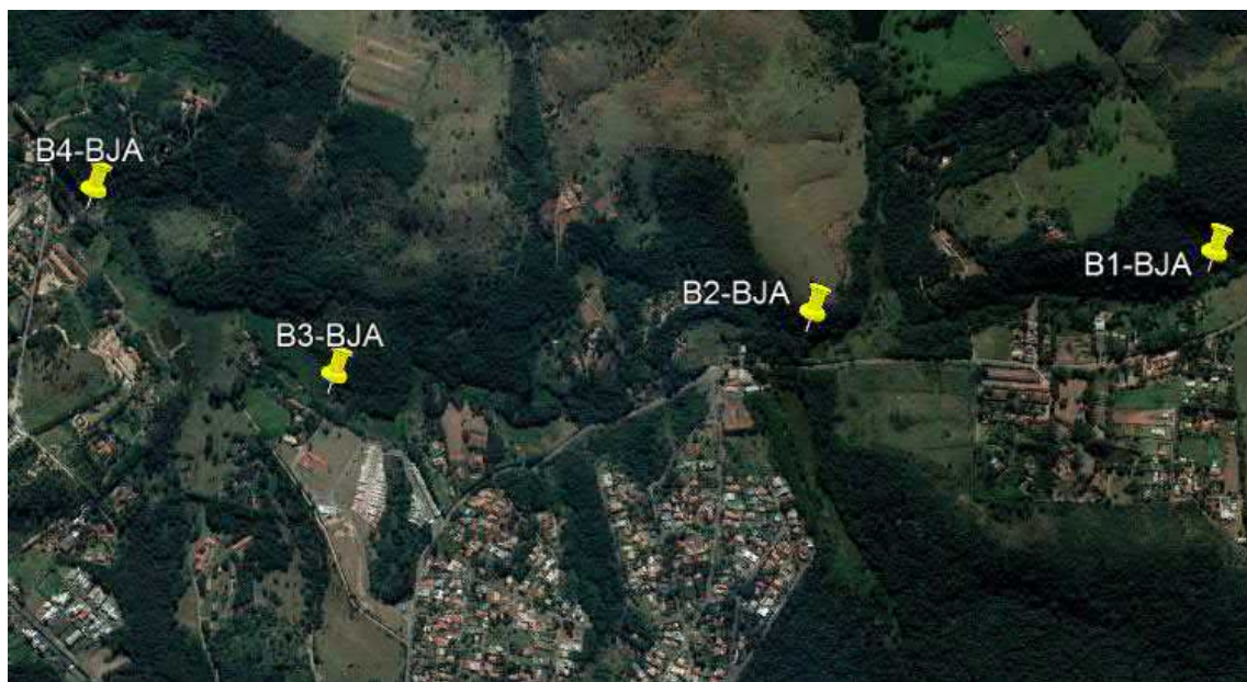
Figura 290. Localização dos barramentos, Sub Bacia Bom Jardim.
