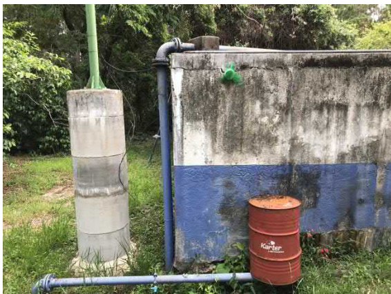
Figura 135. Vista da entrada do reservatório de 120m 3 .
