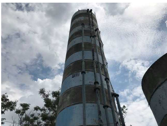
Figura 133. Vista do reservatório elevado de 21m 3 .
