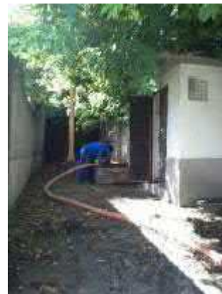
Figura 161. Estação Elevatória - Vida Nova III - Vista 2.
