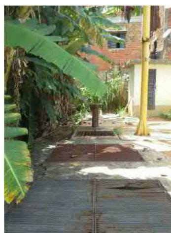
Figura 159. Estação Elevatória - Vida Nova III (Principal) - Vista 2.
