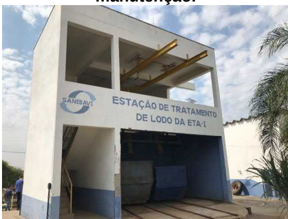
Figura 68. Vista do prédio onde fica o sistema de tratamento de lodo.
