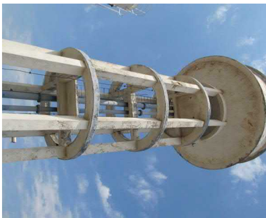
Figura 125. Vista do reservatório elevado de 100m 3 .
