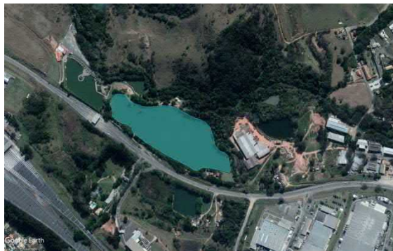
Figura 266. Vista do local da Represa nº 10.
