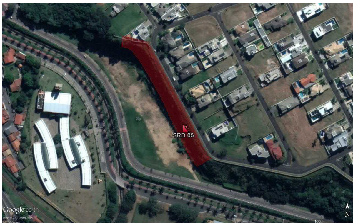
Figura 197. Área de Risco SRD 05 - Talude Terras de Vinhedo.
