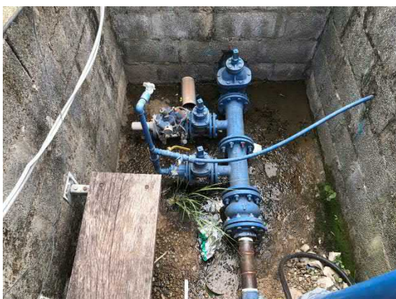
Figura 106. Vista da válvula de retenção de segurança.
