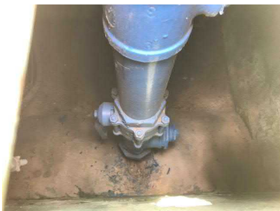
Figura 109. Vista da válvula de retenção de segurança.
