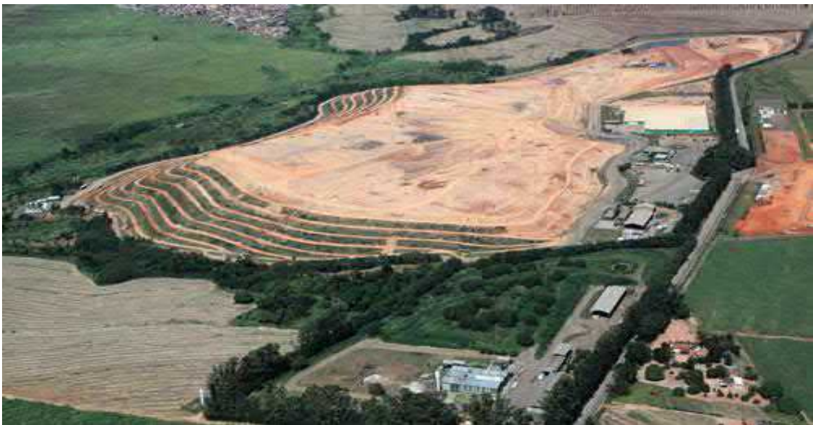
Figura 225. Centro de Gerenciamento de Resíduo – CGR Paulínia.
