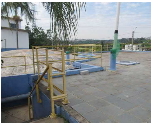
Figura 123. Vista do reservatório semi enterrado de 450m 3 .
