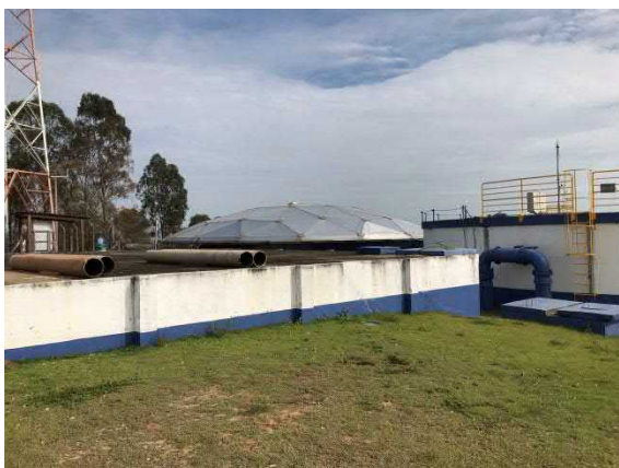
Figura 121. Vista do reservatório semi-enterrado de 400m³.
