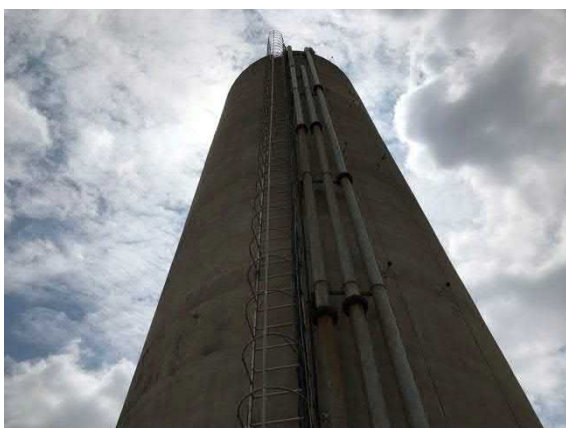
Figura 129. Vista do reservatório elevado de 102m 3 .
