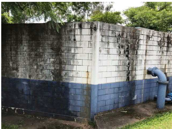
Figura 127. Vista do reservatório apoiado de 730m 3 .
