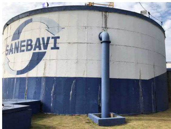
Figura 120. Vista do reservatório apoiado de 1.000m³.
