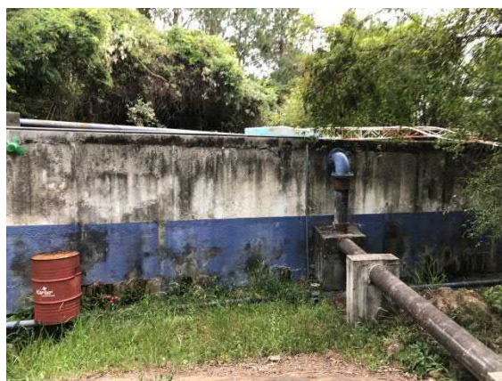
Figura 138. Vista da tubulação de entrada do reservatório.
