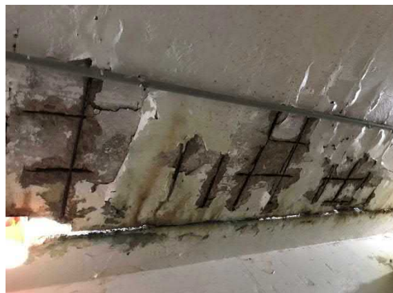
Figura 65. Vista da estrutura da passarela superior em evidência.
