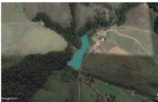
Figura 264. Vista do local da Represa nº 8.
