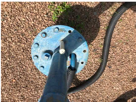
Figura 102. Vista da laje sanitária e tubete de nível.
