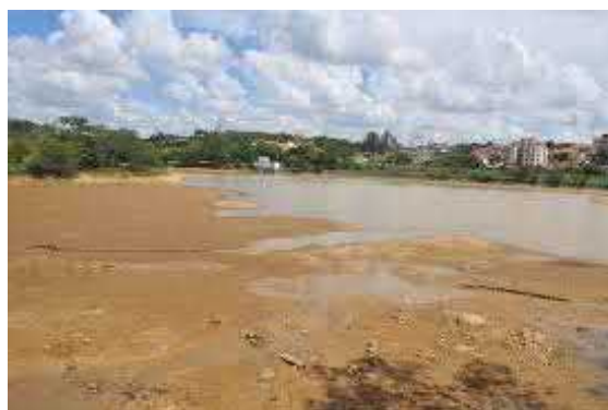
Figura 33. Vista do Barramento na represa 1 durante a estiagem.
