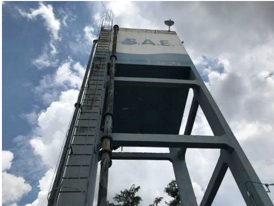
Figura 150. Vista geral do reservatório elevado de 60m³.
