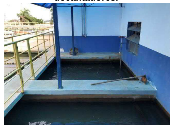
Figura 59. Vista do sistema de filtração.
