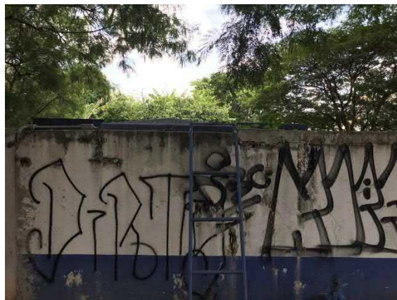
Figura 143. Vista do acesso para laje de cobertura do reservatório.
