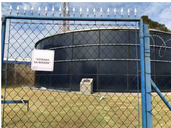
Figura 119. Vista geral da entrada do sistema de reservação.
