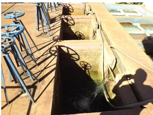
Foto 3.20 – Vista geral de uma das unidades de filtro rápido por gravidade
