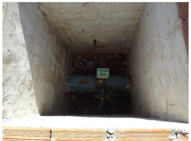
Foto 3.6 – Macromedidor instalado em uma das saídas da captação superficial
