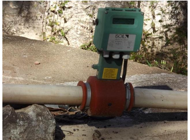
Foto 3.11 – Detalhe de macromedidor instalado no Poço P1
