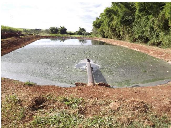
Foto 3.56 – Vista geral da lagoa anaeróbia com excesso de sobrenadante
