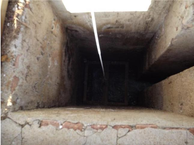
Foto 3.63 – Detalhe de caixa que encaminha esgoto para ETE 2
