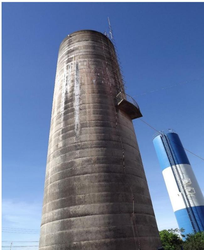
Foto 3.30 – Vista do REL Vila Nova, com detalhe para vazamento na lateral
