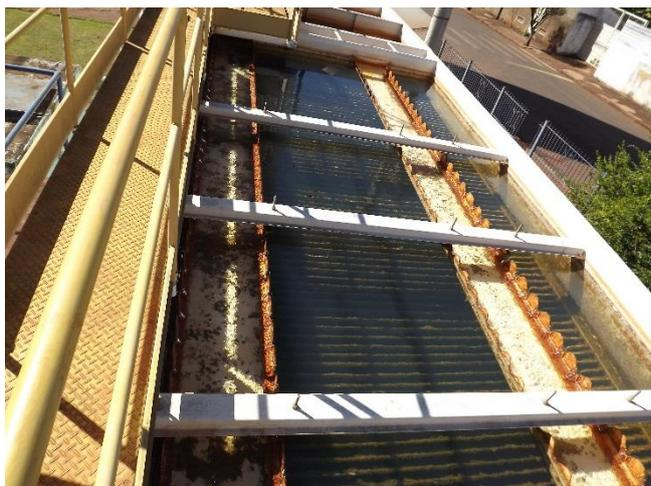
Foto 3.22 – Detalhe do decantador laminar ascendente de contato
