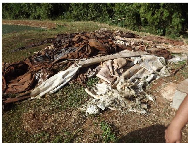
Foto 3.59 – Detalhe de bags utilizados para a retirada e secagem de lodo das lagoas
