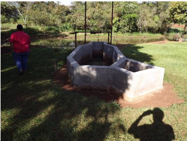
Foto 3.3 – Caixa de passagem para captação de água superficial
