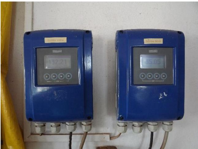
Foto 3.26 – Detalhe de medidores de vazão na entrada da ETA
