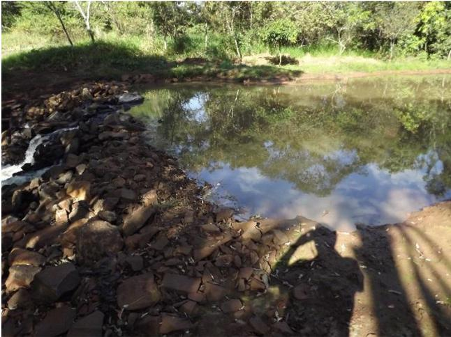
Foto 3.1 – Barragem (enrocamento) para captação de água superficial no Córrego do Sucuri
