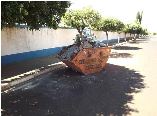
Foto 3.81 – Caçamba de acondicionamento de RCC
