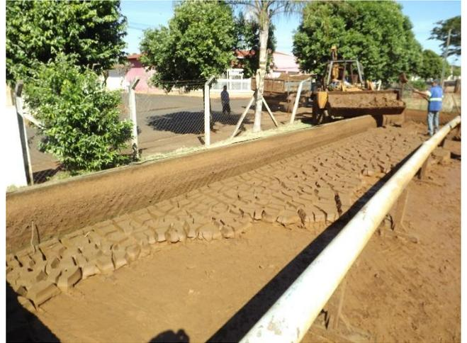
Foto 3.25 – Detalhe do leito de secagem de lodo com retirada
