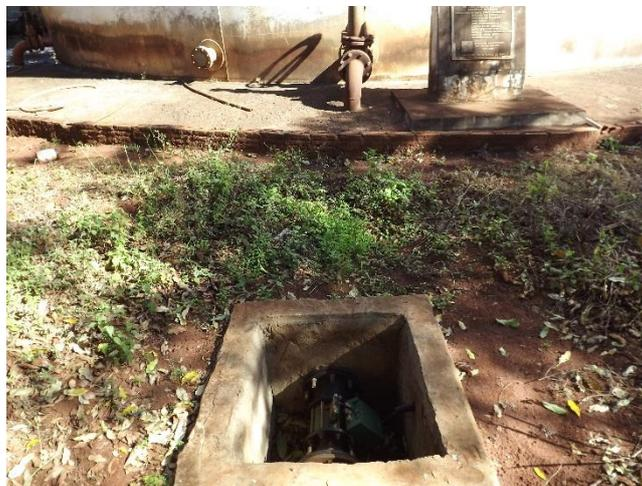
Foto 3.33 – Detalhe do macromedidor instalado na saída do RAP Redona
