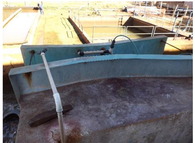
**Foto 3.17 – Ponto de aplicação de policloreto de alumínio (coagulante) na entrada da ETA**
