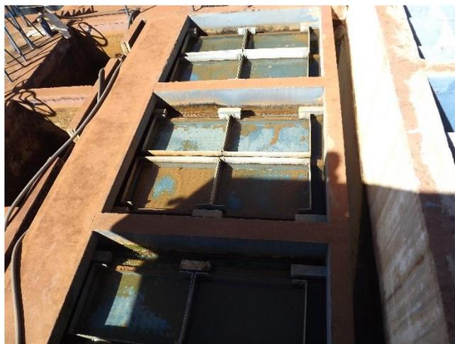
Foto 3.19 – Detalhe conjunto de decantadores do tipo “bandeja”
