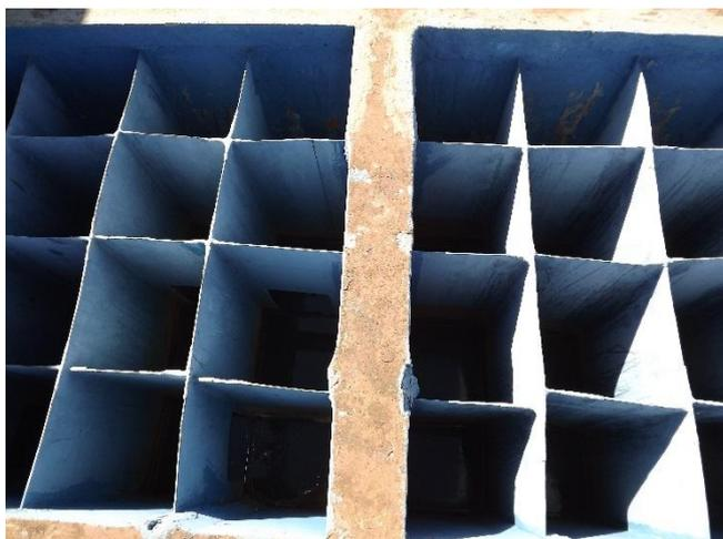
Foto 3.18 – Vista geral de floclador hidráulico com chicanas de fibra de vidro
