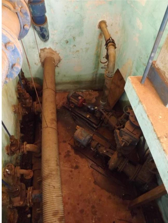
Foto 3.47 – Conjuntos motobomba para retrolavagem e recalque para REL Vila Nova
