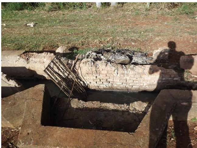
**Foto 3.54 – Detalhe da estrutura de gradeamento parcialmente destruída**
