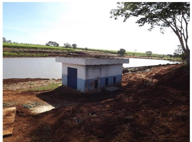
**Foto 3.8 – Vista geral do abrigo das motobombas de recalque para ETA**
