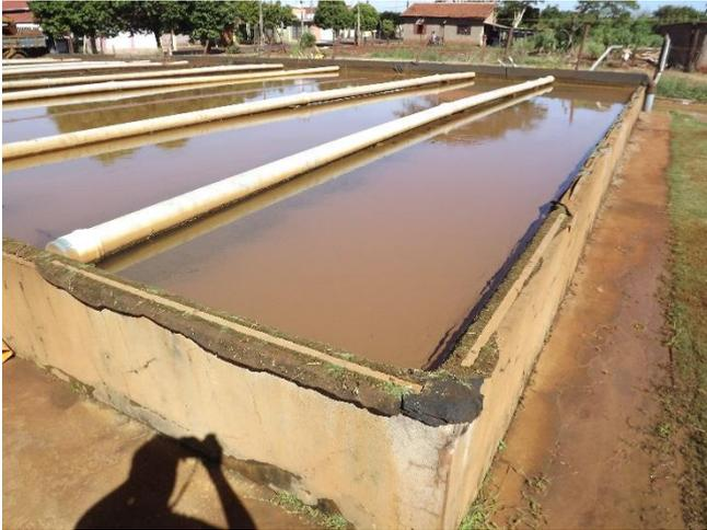
Foto 3.24 – Vista do sistema de tratamento de lodo da ETA
