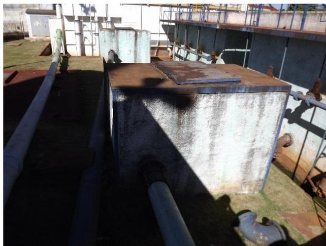
Foto 3.23 – Detalhe da caixa de passagem para retrolavagem dos filtros
