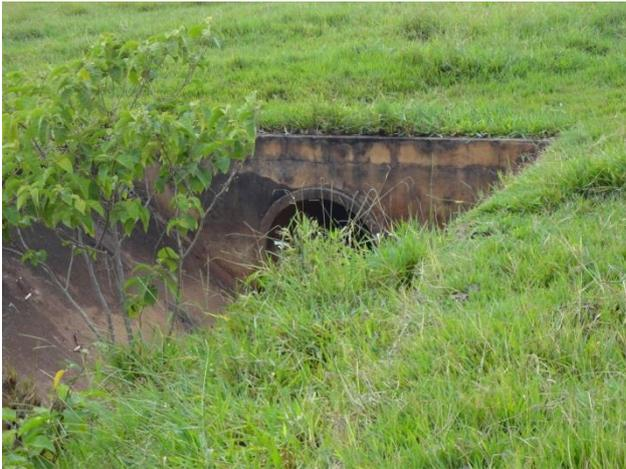
Foto 3.7 – Estrutura de lançamento de águas pluviais
