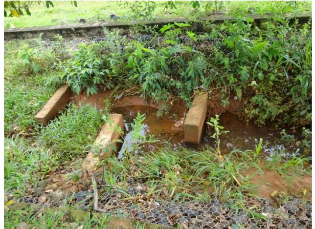
Foto 3.8 – Dissipador de energia do lançamento
