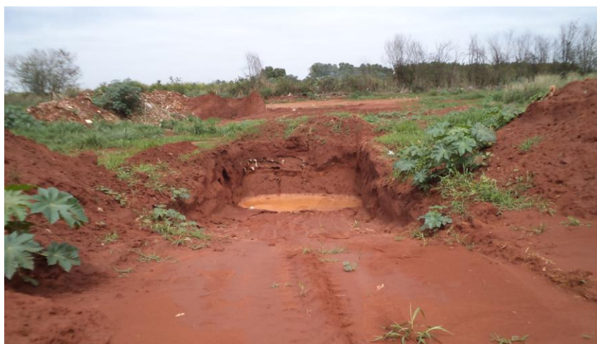
Figura 9: Vala escavada para recepção de resíduos.
