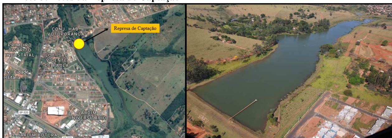
Foto 3: Fotos da Represa de Captação
