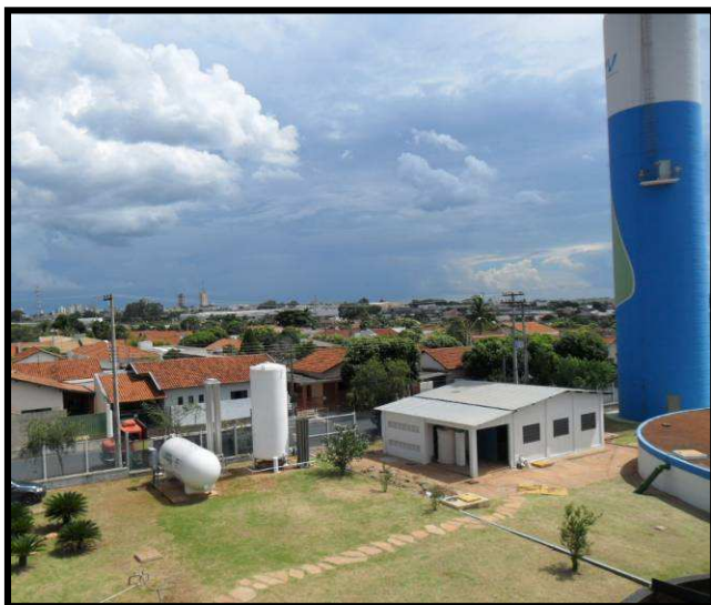
Foto 11: Reservatório Elevado - Poço Profundo Zona Norte
