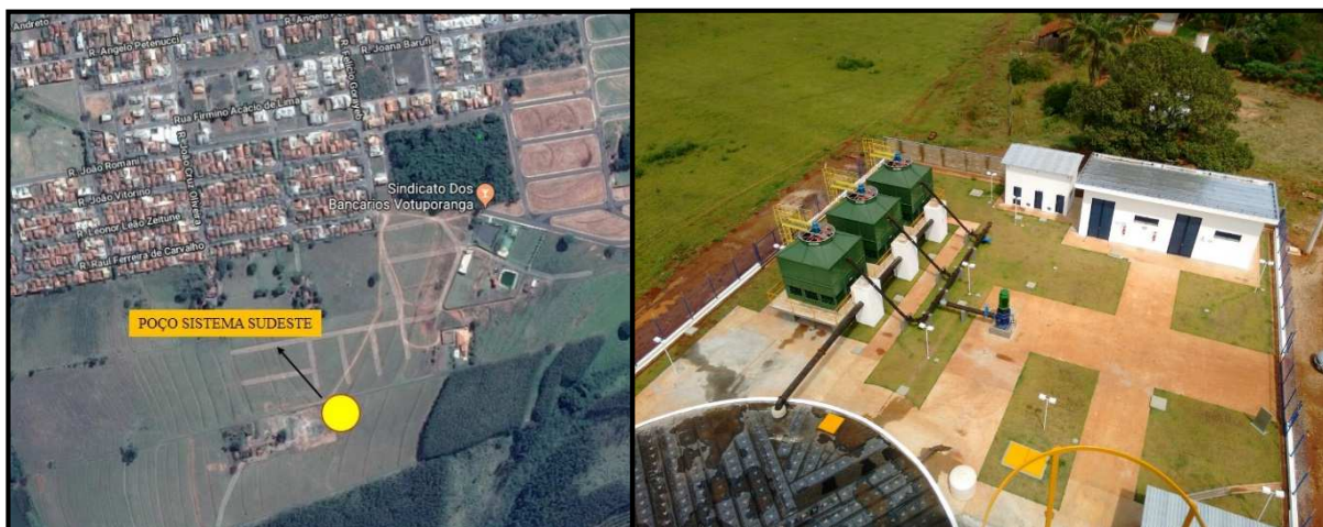
Foto 6: Imagem do poço profundo Zona Sudeste (2017)
