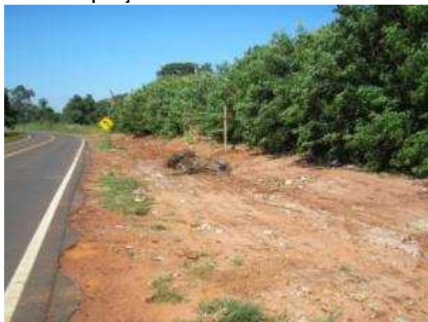
Antigo “ponto de caçamba” já desativado.
