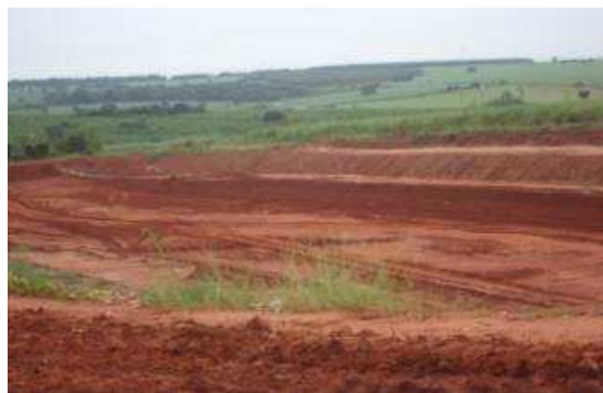
Aterro: vista geral.
