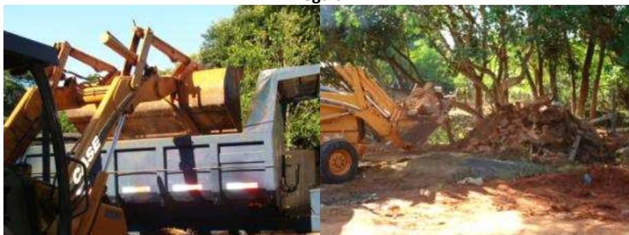
Figuras 32e 33: Caminhão e maquinário utilizados pela secretaria de obras para limpeza de ponto de descarte irregular.
