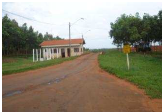
Entrada do aterro – guarita/balança.
