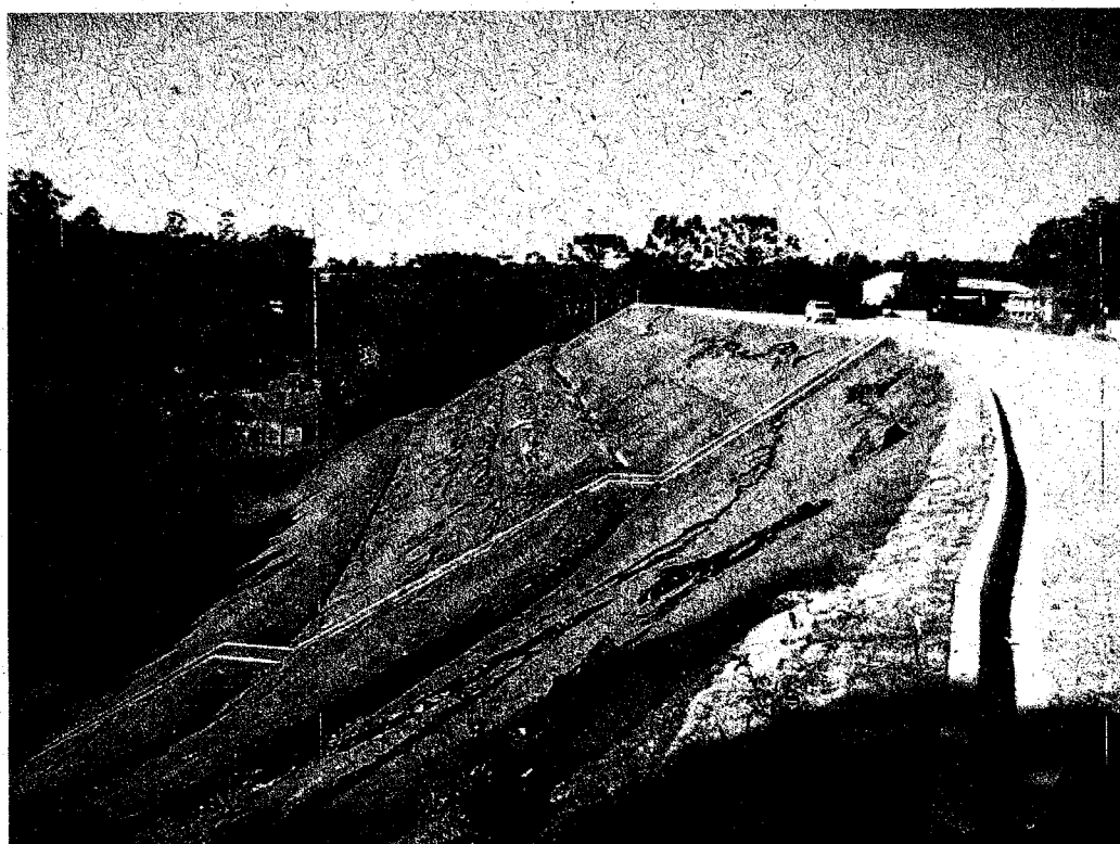
Foto 6 - Vista da saída do aterro e da drenagem
