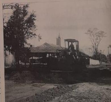
Os maquinários procederam movimentação de terra visando pavimentação asfáltica.
