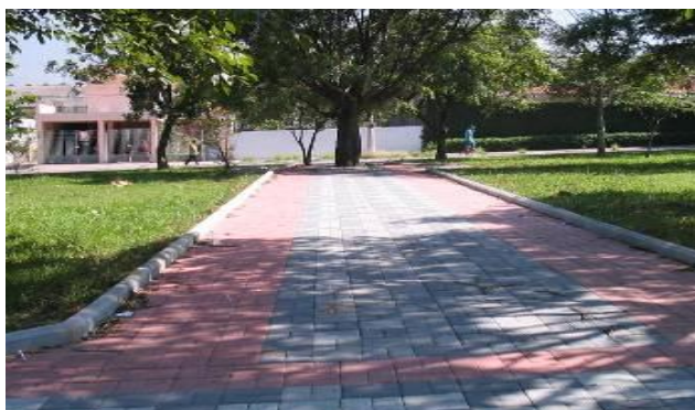
Reconstrução de passeios
