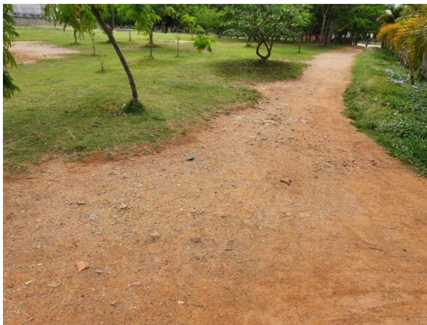
Imagem 15 - Material detritico com restos de inertes compondo setores aterrados.
