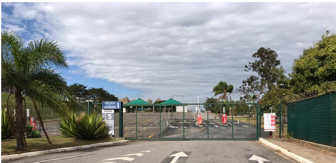
Imagem 52 - Portaria de entrada de veículos e pedestres
