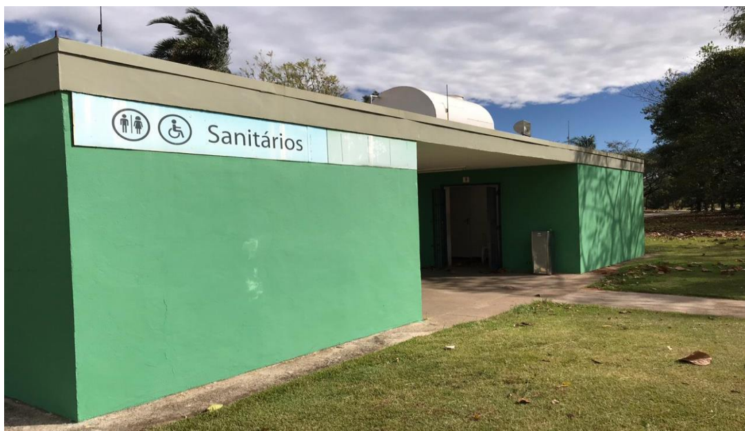
Imagem 66 - Conjunto de sanitários.
