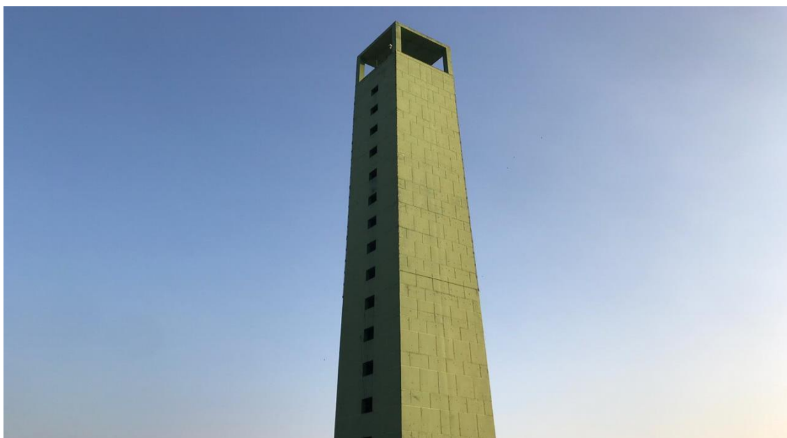
Imagem 62 – Torre de caixa d'água, inconclusa, apelidada de Mirante.
