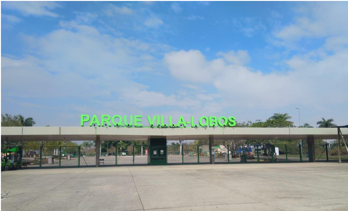
Imagem 50 - Entrada Principal uso exclusivo para pedestres e ciclistas
